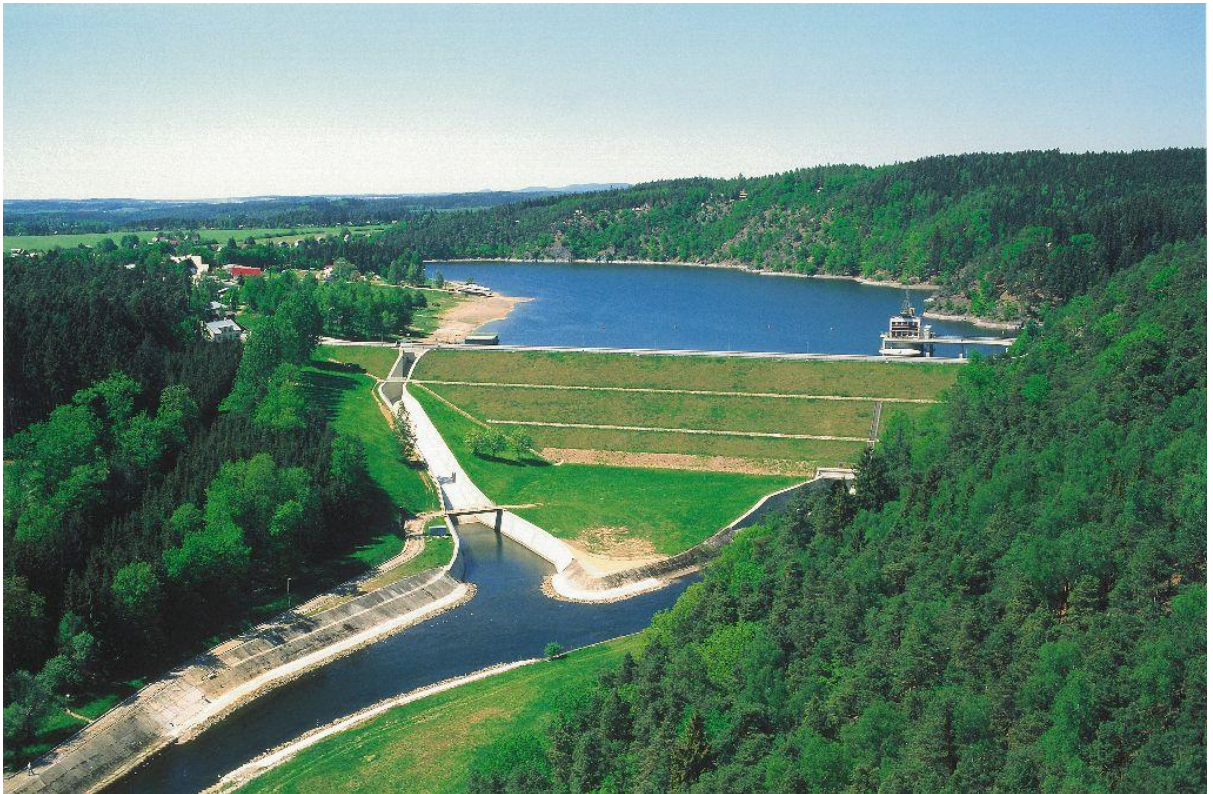
Obrázek č. 4.18 – Přehradní hráz a vodní elektrárna Hracholusky (Zdroj: Hracholusky, 2017)
