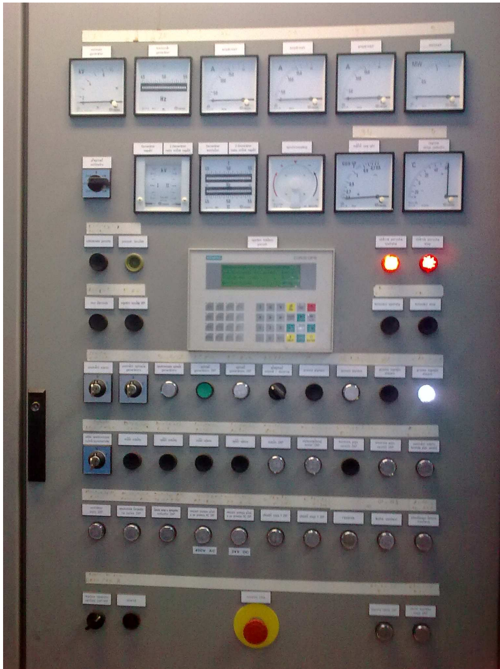
Obrázek 3.5 : Ovládací panel na provozování generátoru [26]
