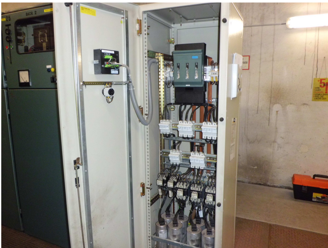
Obrázek 1.8 : Rozváděč pro centrální kompenzaci závodu 200 [kVAr]
