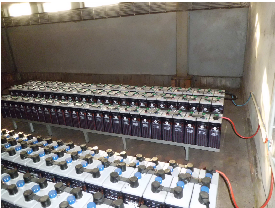
Obrázek 1.9 : Baterie na výrobu ovládacího napětí 2-220 [V] DC [26]
