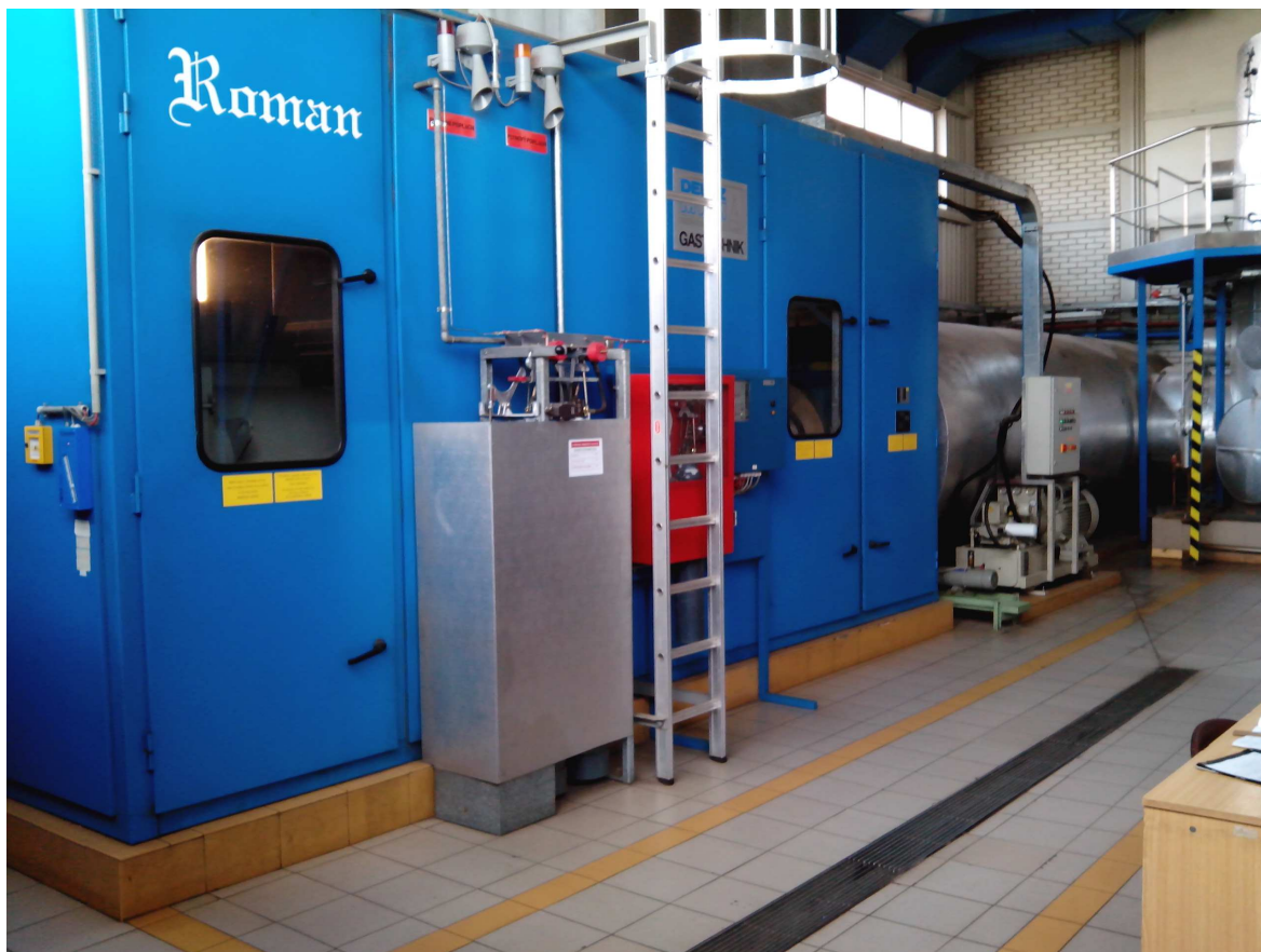
Obrázek 3.2 : Kogenerační jednotka v protihlukovém krytu [26]
