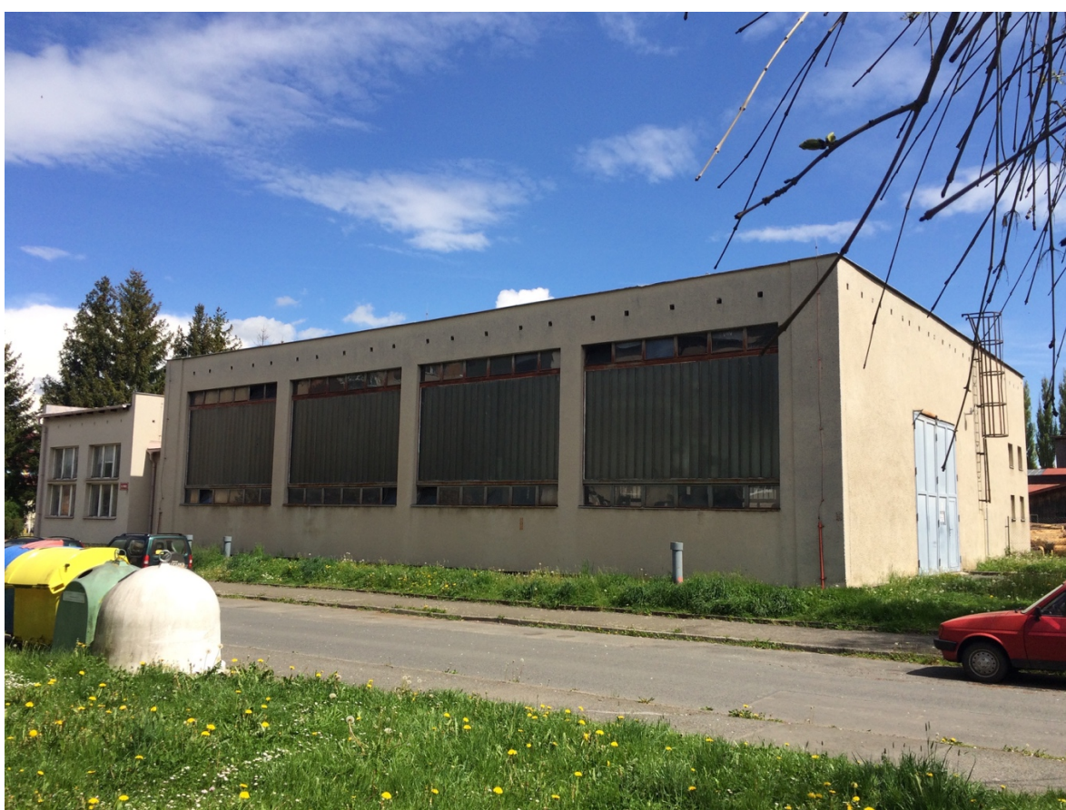
Obr. 2.2: Stávající budova výměňkové stanice
