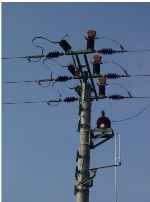
Obr. 2.1: DOÚ komorový, olejový [27]
