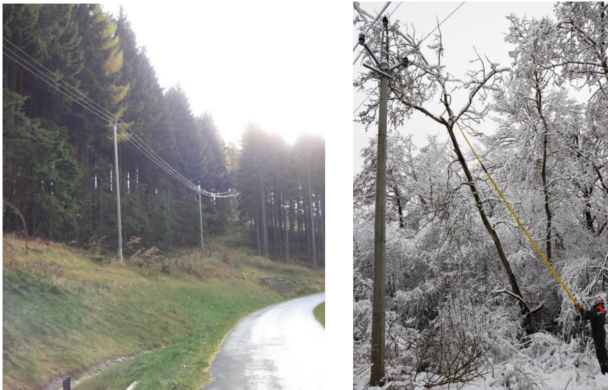
Obr. 5.10 Lesní průsek venkovního vedení VN (převzato z: [33], [34])
