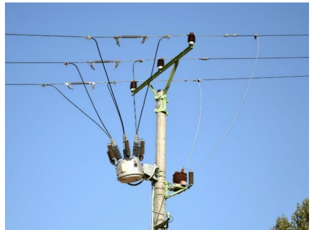
Obr. 5.1 Recloser Hawker Siddeley Switchgear (převzato z:[30])
