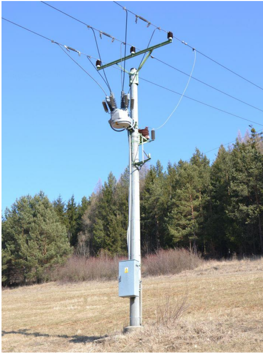
Obr. 5.2 GVR Recloser Hawker Siddeley Switchgear (převzato z: [30])
