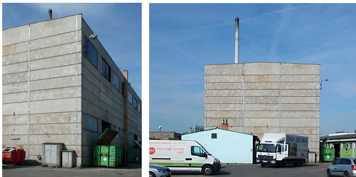
Obr. 1.1: Spalovna NO Plzeň (zdroj vlastní).
