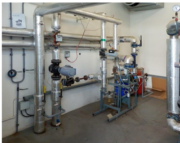
Obr. 2.17: Místo předání tepla pro vlastní spotřebu (zdroj vlastní).
