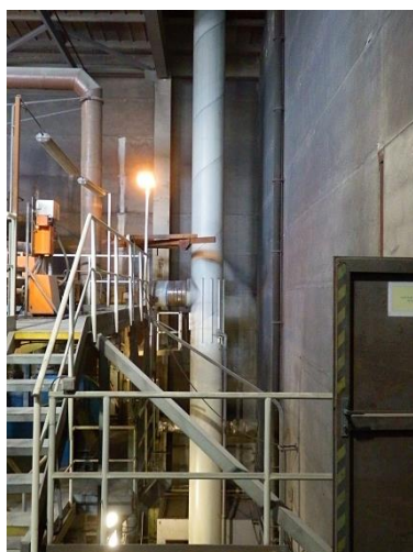
Obr. 2.15: Komín – spodní vnitřní část (zdroj vlastní).
