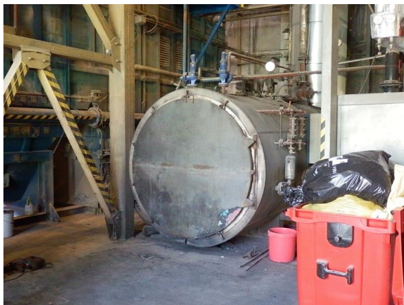
Obr. 2.6: Spalinový výměník tepla (zdroj vlastní).
