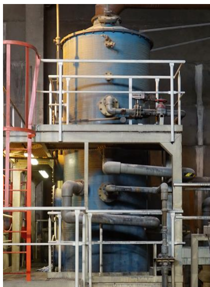
Obr. 2.13: Pračka kouřových spalin (zdroj vlastní).
