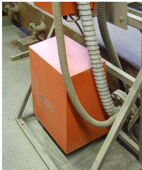
Obr. 2.14: Měřicí úsek spalinového potrubí (zdroj [3]).
