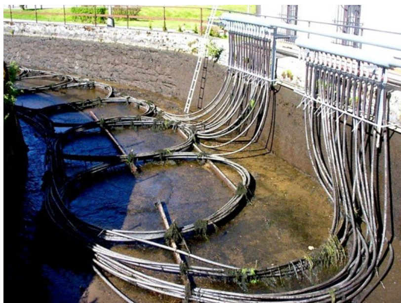
Obr. 8 Reálná ukázka využití TČ voda/voda s povrchové vody [9]
