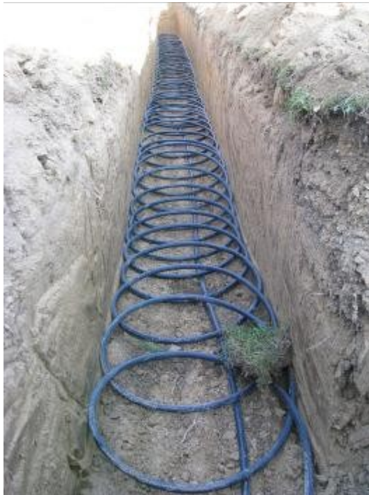
Obr. 10 Ukázka položení trubkových jímačů tepla [15]
