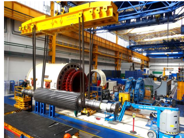
Obr. 64 Jeřábový převoz rotoru do pracoviště
