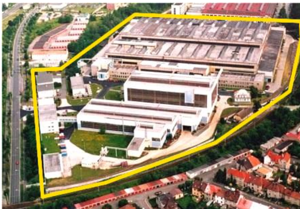
Obr. 32 Letecký pohled na společnost BRUSH SEM s.r.o. [20]
