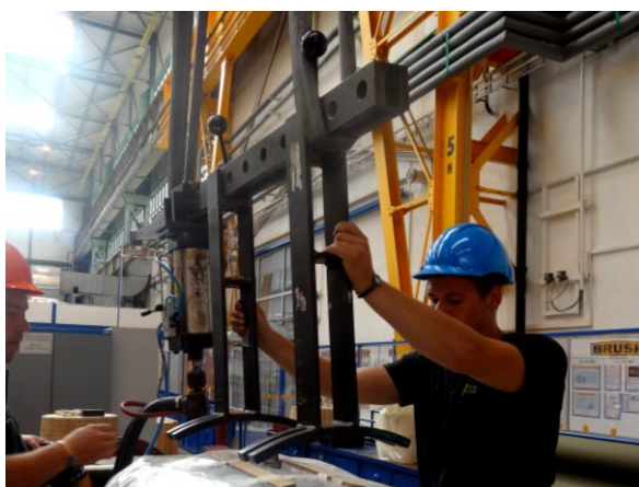
Obr. 125 Montáž pájecí konstrukce
