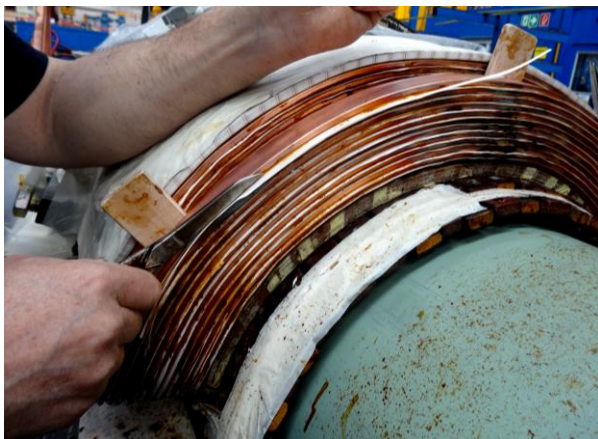
Obr. 109 Okraje izolace odštířívány nůžkami
