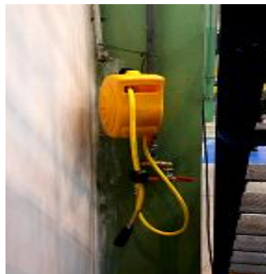
Obr. 11 Instalace vzduchového navijáku
