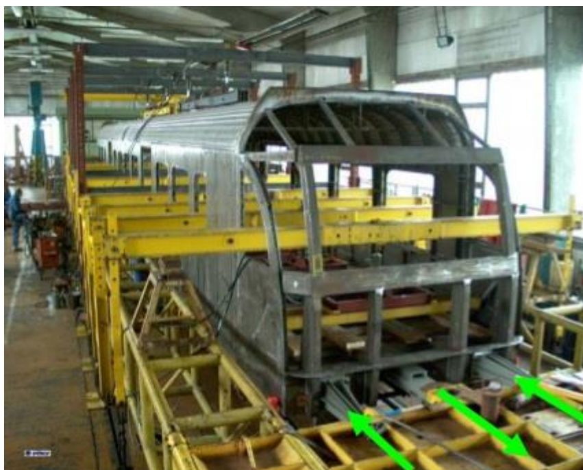
Obrázek 2 Statická zkouška hrubé stavby skříně [12]
