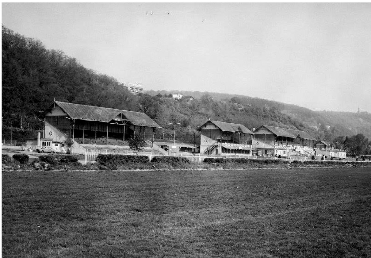
Příloha č. 22: Celkový pohled na secesní tribuny na závodišti Velká Chuchle.
