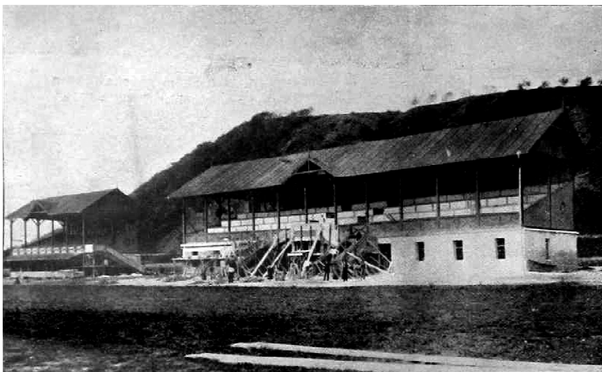
Příloha č. 20: Dokončovací práce na jedné z tribun v srpnu 1906.
