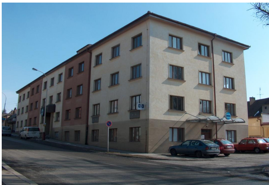
Obrázek 18 - Administrativní budova VSP Data
