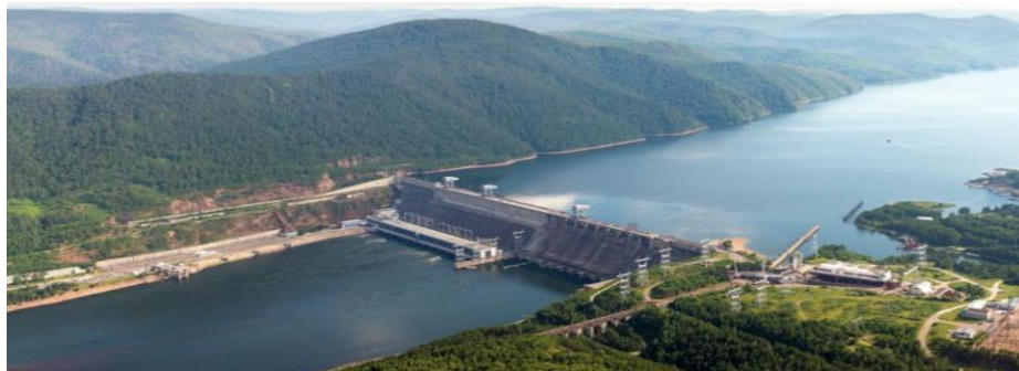
Obr. 9.8 Krasnojarská vodní elektrárna [76]
