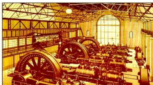
Obr. 9.1 Strojovna vodní elektrárny na řece Way [74]
