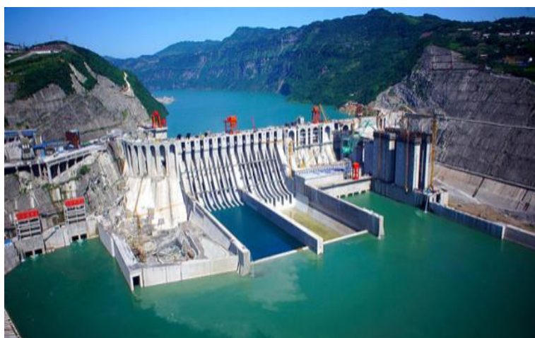
Obr. 9.6 Vodní elektrárny Xiangjiaba [78]
