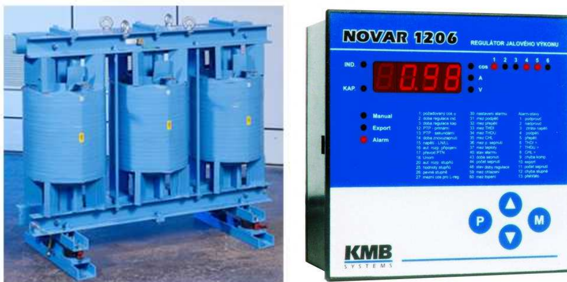
Obr. 37 Hradící tlumivka MANGOLDT a regulátor NOVAR 1206 [13][15]
