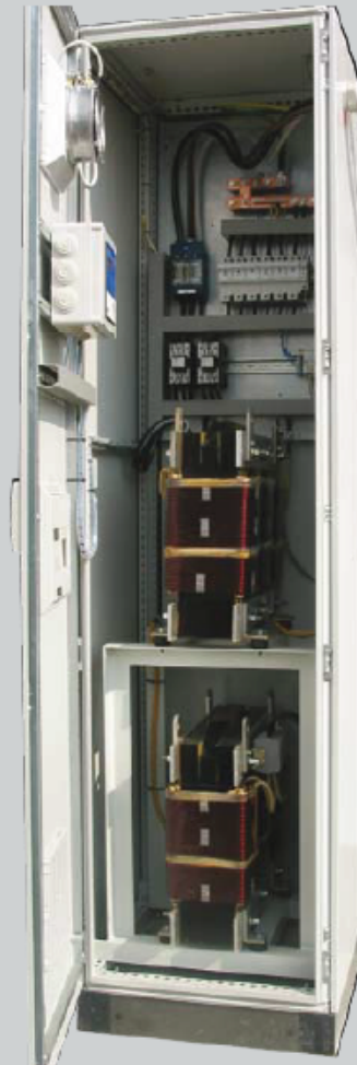
Pohled na dekompenzační pole 80 kvar
