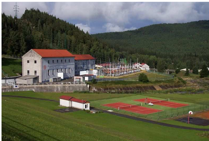
Obr.č. 32 Budova elektrárny a transformační stanice
