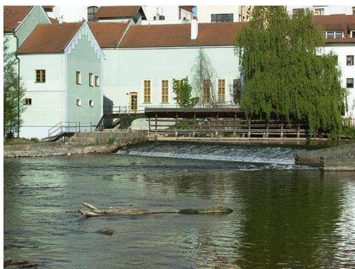
Obr.č. 28 Malá vodní elektrárna v Písku
