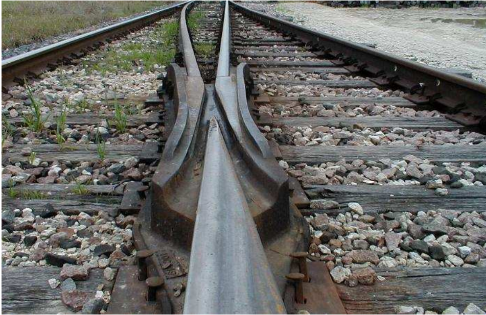
Obrázek 20: Železniční srdcovka jako výrobek z Hadfieldovy oceli
