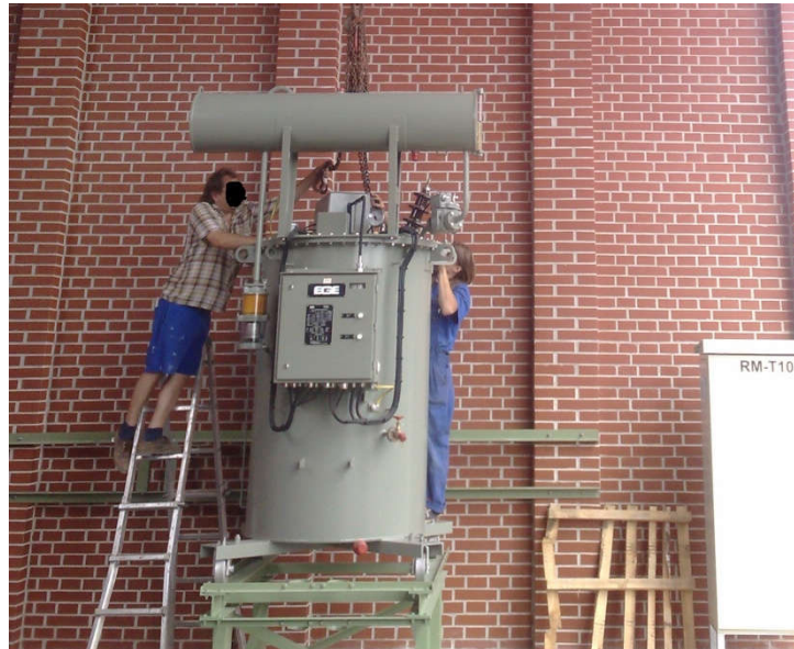
Obrázek 1.5 Montáž zhášecí tlumivky v trafostáně T101 při výstavbě TR Černice 110/22kV roku 2010 (vlastní archiv)
