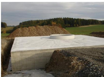
1.3. Betonový základ onshore větrné elektrárny [4]
