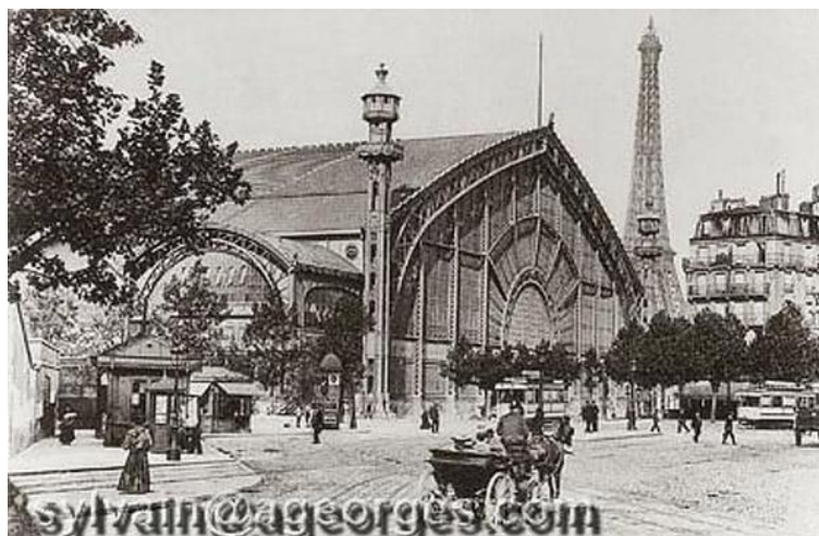
Image 31 : La Galerie des Machines
