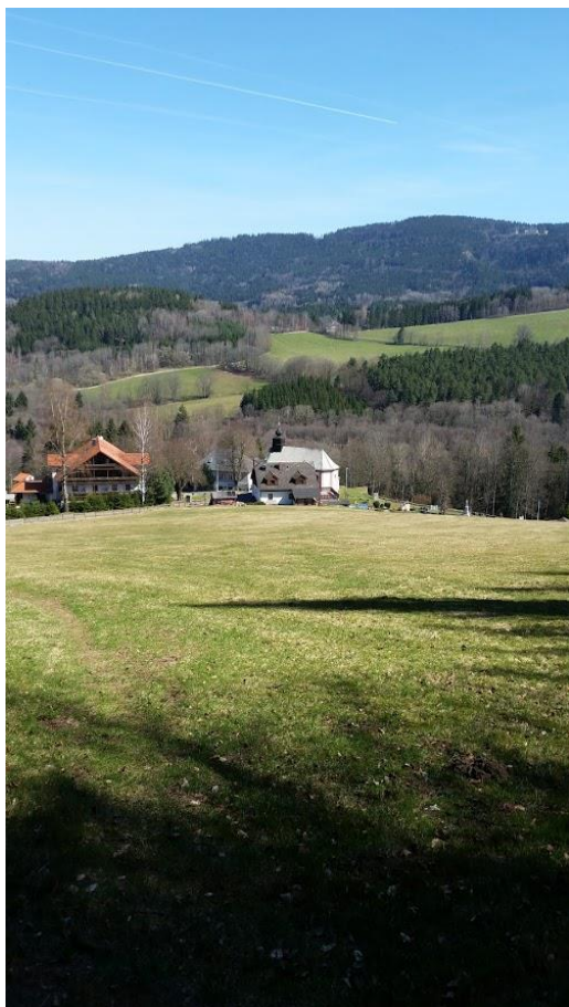
Obrázek 20 Pohled na Kollerův kostel a Hamry Zdroj: vlastní fotodokumentace
