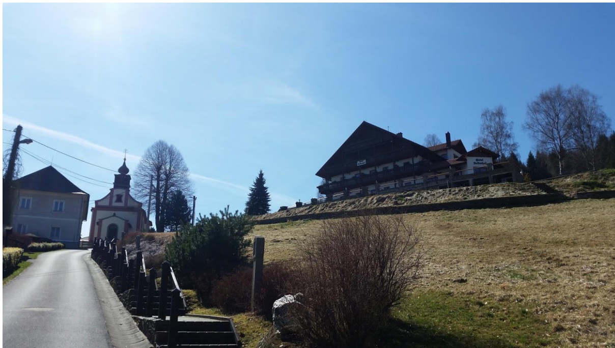
Obrázek 19 Pohled na Kollerův kostel a Hamry Zdroj: vlastní fotodokumentace
