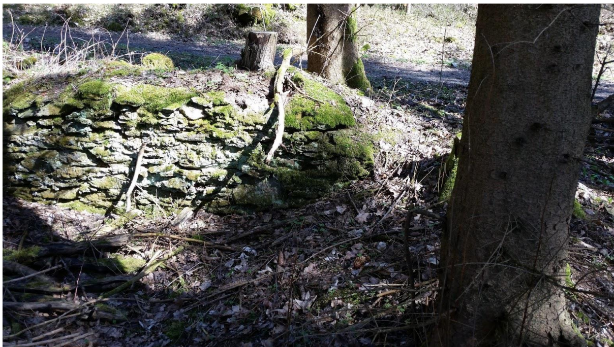
Obrázek 14 Základy chalupy na Rödrovském Dvorci Zdroj: vlastní fotodokumentace
