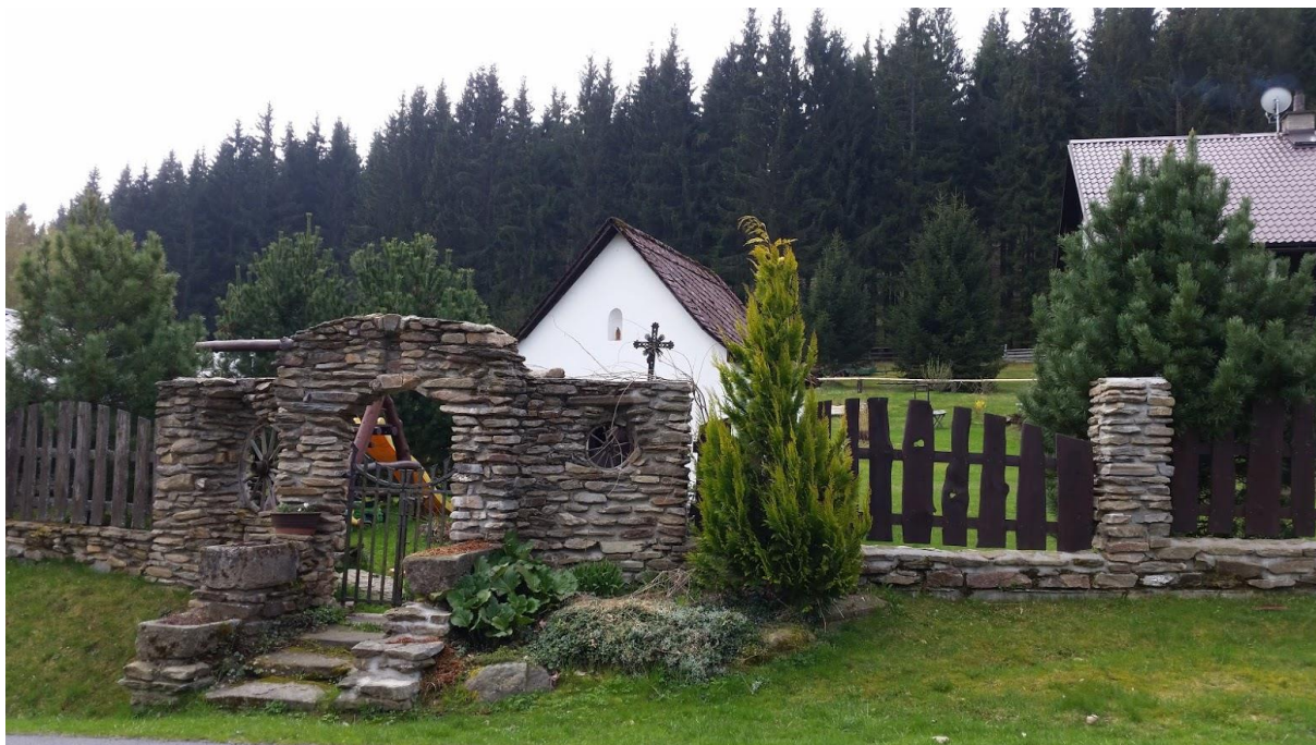
Obrázek 22 Štefanův Dvůr Zdroj: vlastní fotodokumentace
