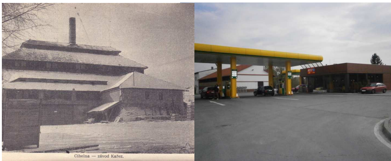
Obrázek č. 17: Panská cihelna, čerpací stanice 2017
