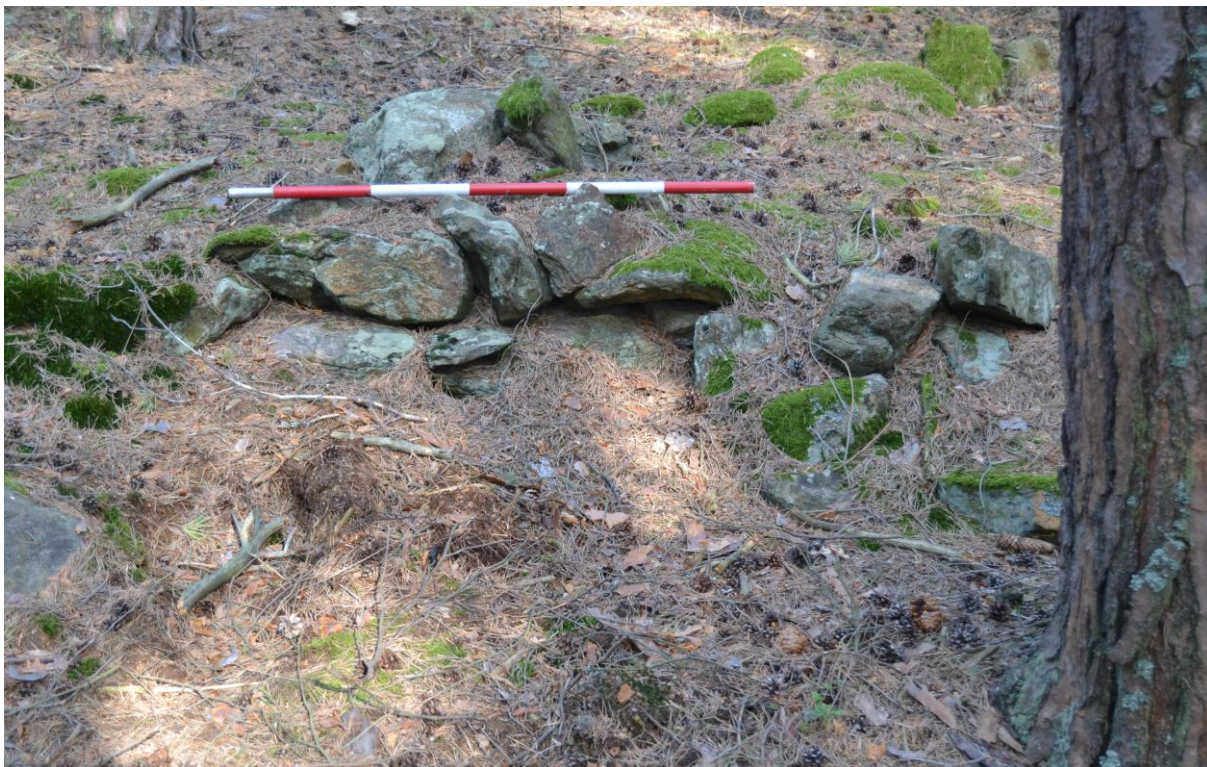
Obr. 27. Hrad u Strašína. Kamenná rovnanina před čelem hradu v pohledu od západu. Foto autor.
