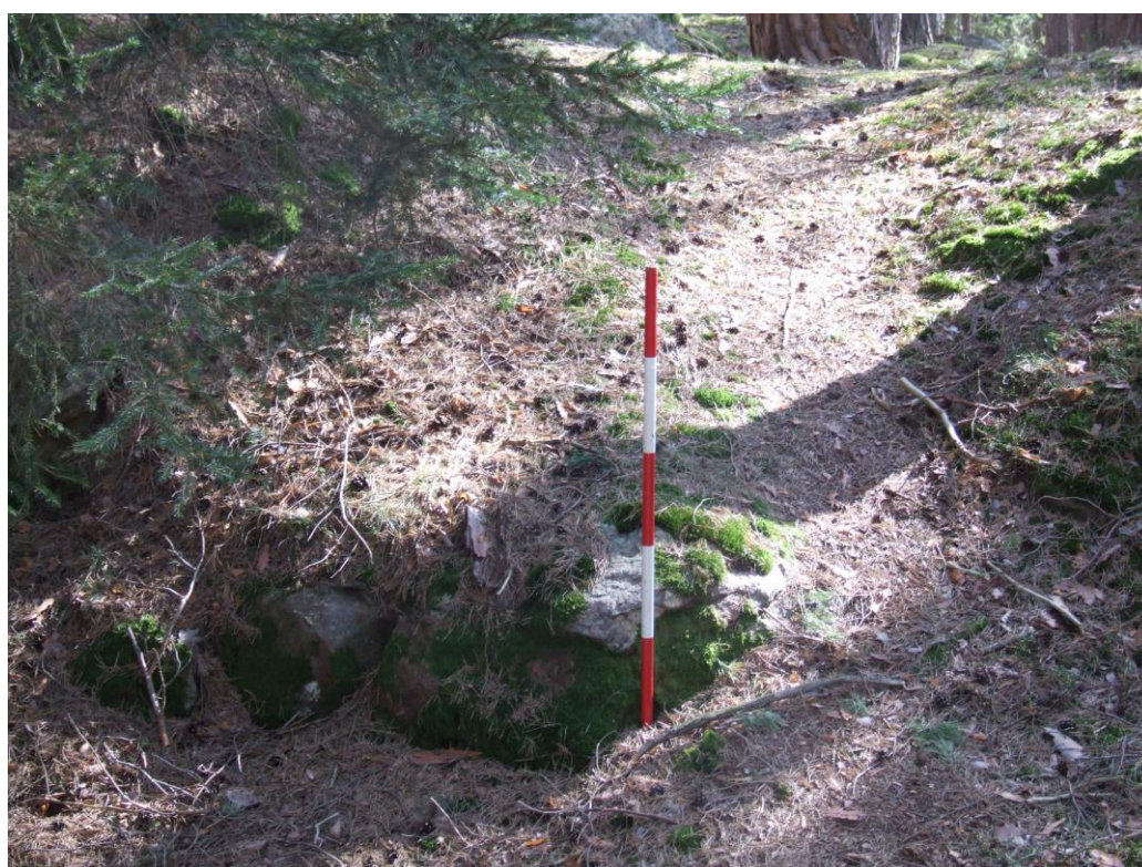
Obr. 18. Hrad u Strašína. Pohled na vnější val z kamenného můstku v místě, kde by měla vzniknout vnější opěra mostu. Foto autor.
