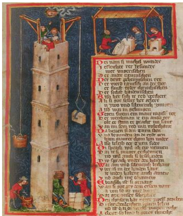
Obr. 1. Stavba věže za použití samosvorných kleští. Iluminace v Kronice Janse Enikela z doby okolo r. 1360 (podle Lehký-Sýkora, 2014).
