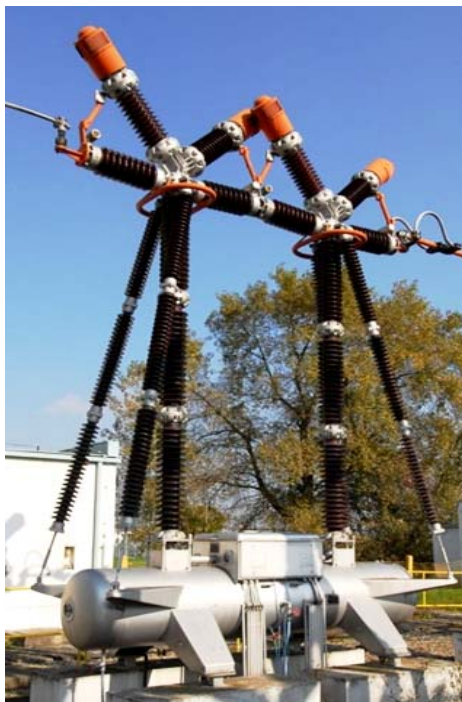
Obr. 4 : Tlakovzdušný vypínač ŠKODA, ty 11VVR 220kV (se 4mi zhášedly); foto JAVYS 2011
