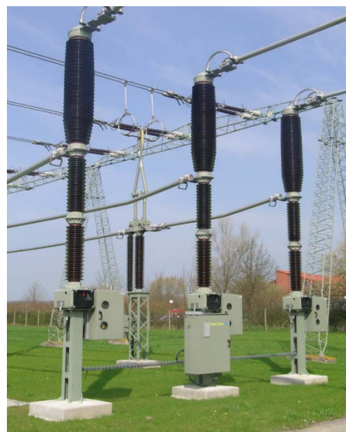
Obr. 12: Vypínač Siemens 3APIFI-245kV.
