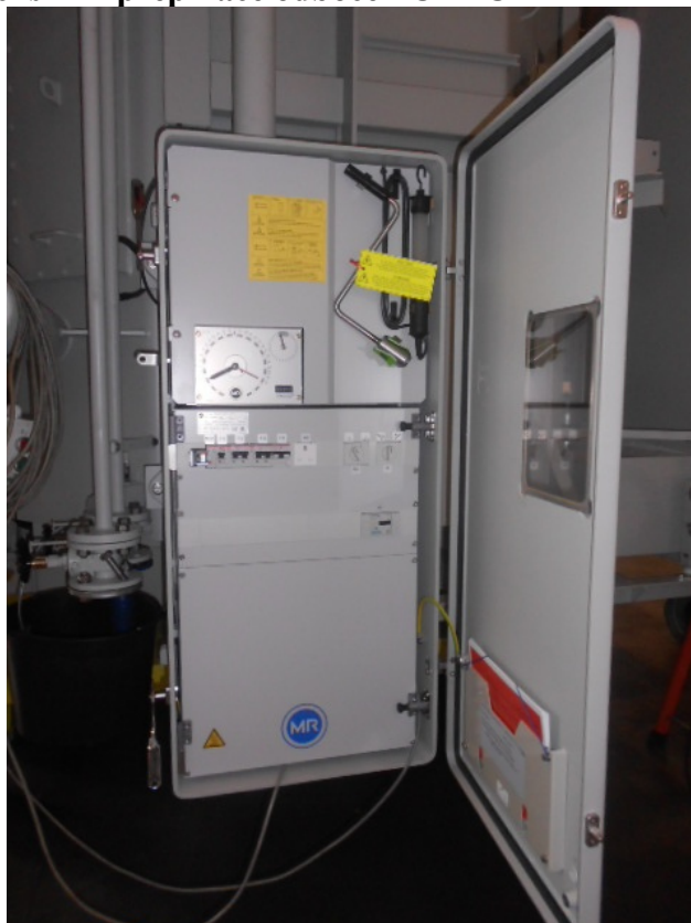
Obrázek 11 - Ovládací skříň OLTC
