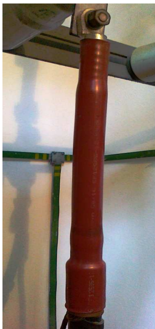
Obr. 6b Kabelová koncovka teplem smršťitelná
