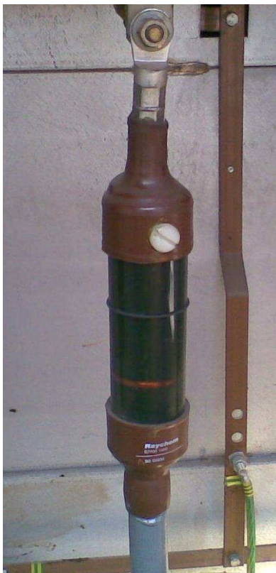
Obr. 3 Dolévací koncovka
