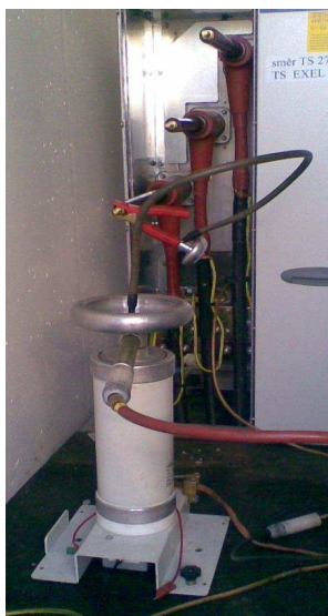
Obr. 9b Připojení vazebního kondenzátoru
