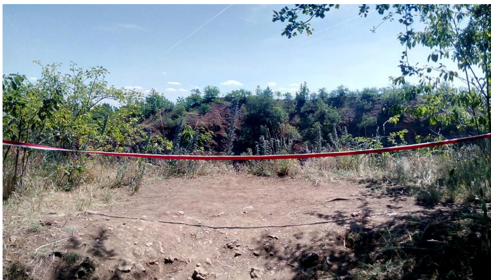
Příloha 4: Páska lemující okraj lomu (jeden ze způsobů zabránění vstupu na hranu) (zdroj: vlastní foto)
