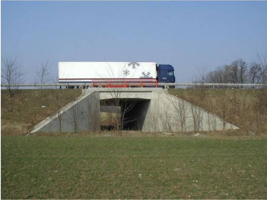
Obrázek 16: Pojžděný most Ledce (Zdroj: dálnice.com, foto: © Jan Slovák)
