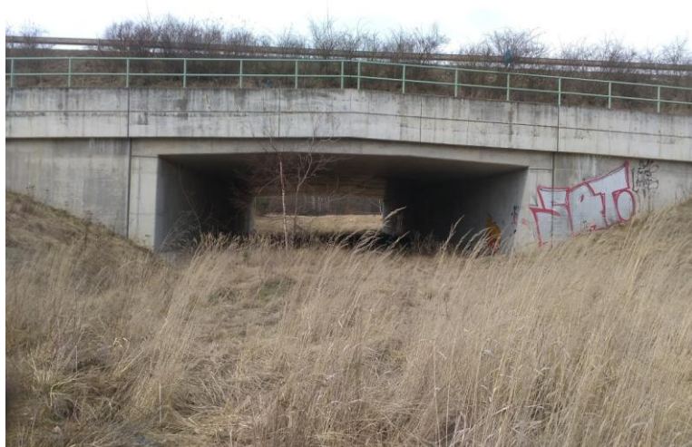
Obrázek 50: Objekt č. 3 na silnici č. 27
