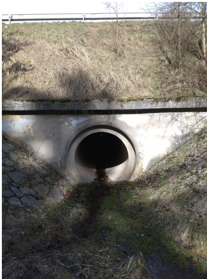
Obrázek 73: Propustek č. 2 na silnici č. 26 východ (foto vlastní)
