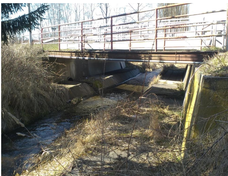
Obrázek 25: Propustek č. 1 obec Líně na silnici č. 26 západ
