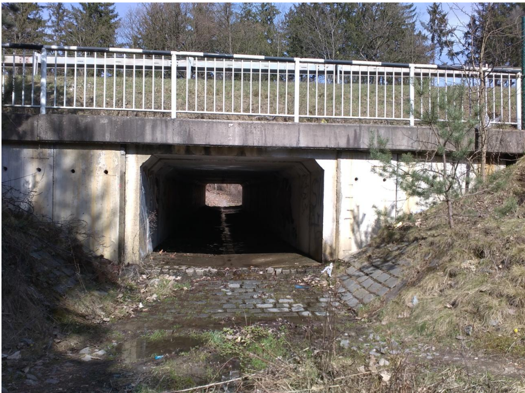
Obrázek 17: Přesýpaný most silnice č. 26 Rokycanská (Zdroj: vlastní foto)
