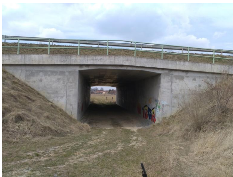
Obrázek 51: Objekt č. 5 na silnici č. 27
