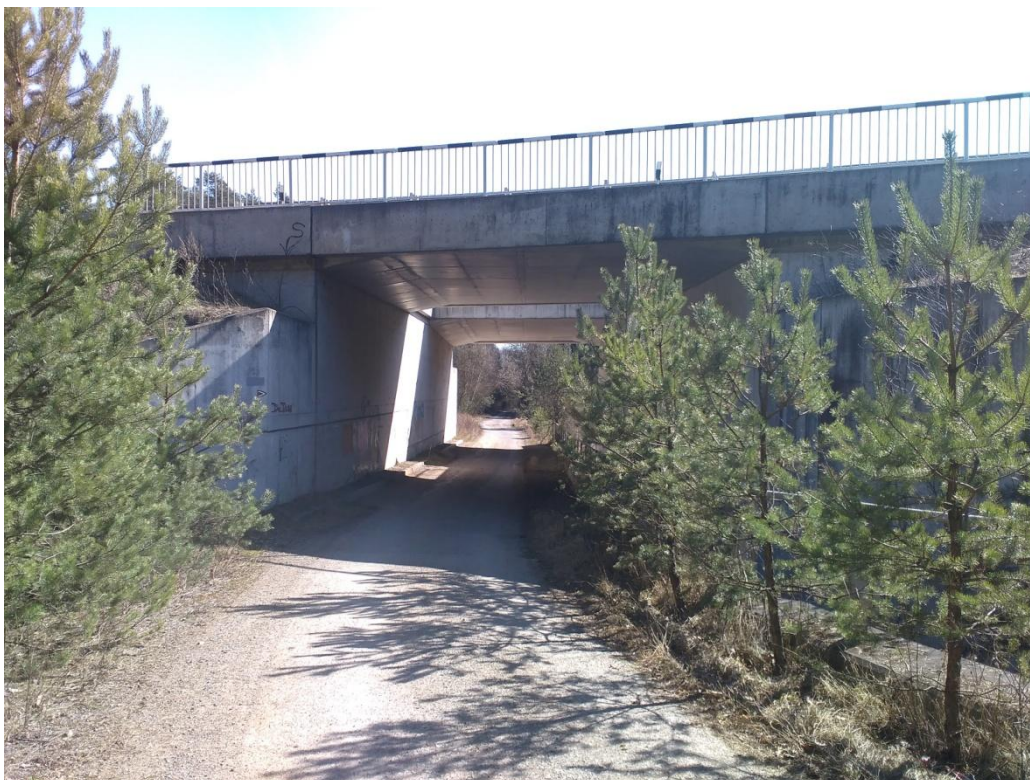
Obrázek 69: Druhá strana vyústění objektu č. 2 silnice č. 26 západ (fotografie vlastní)
