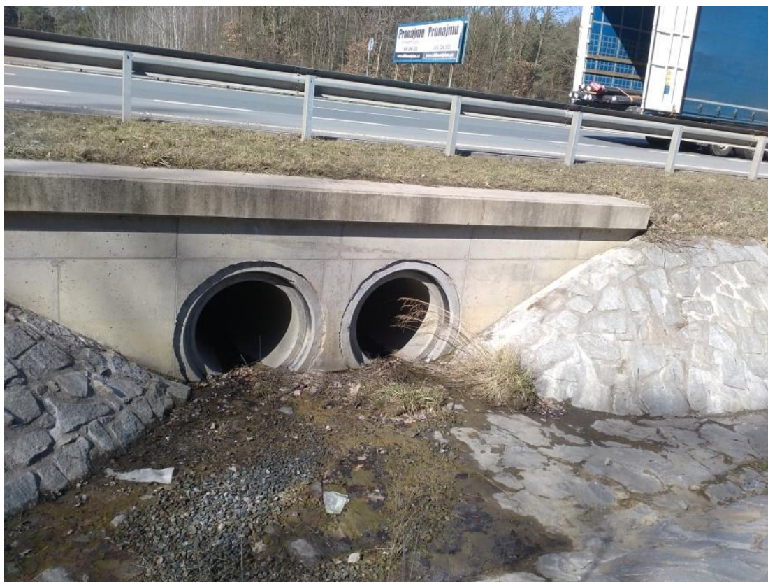
Obrázek 71: Propustek č. 4 pro odvod vody Nová Hospoda silnice č 26 západ (foto vlastní)
