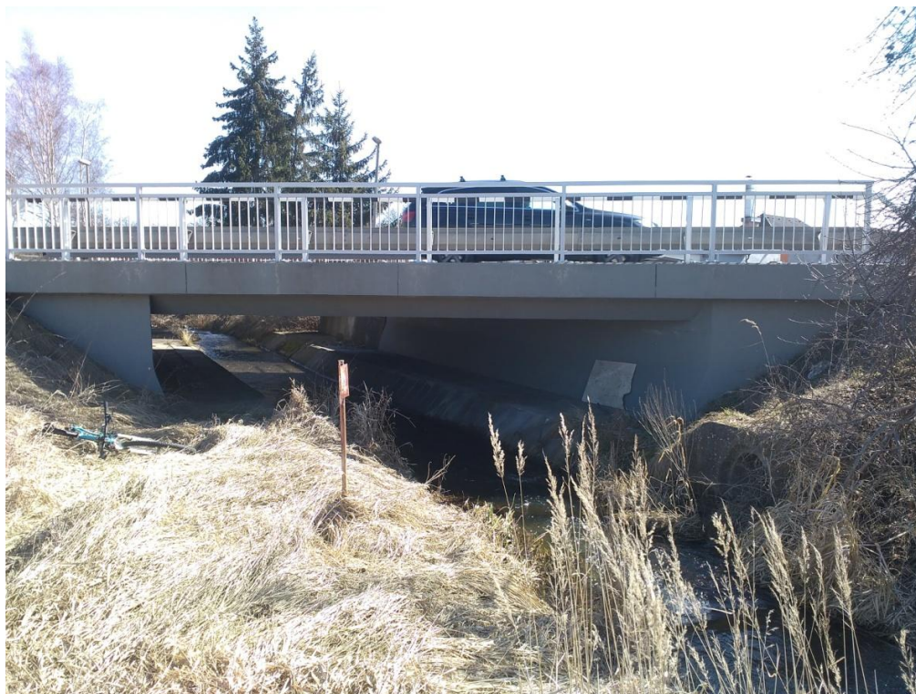
Obrázek 66: Druhá strana propustku č. 1 obec Líně silnice č. 26 (foto vlastní)
