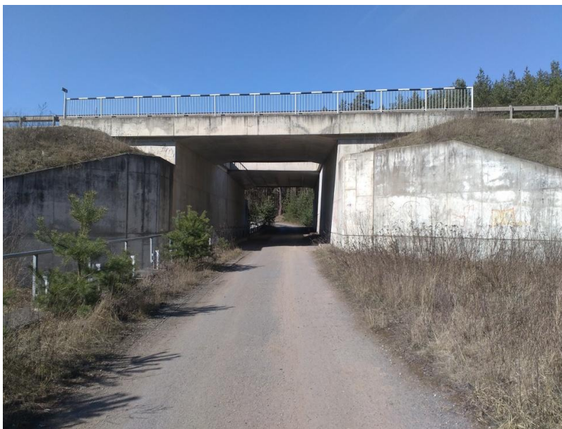
Obrázek 24: Podchod č. 2 silnice č. 26 západ
