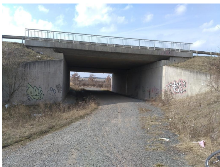
Obrázek 52: Objekt č. 6 na silnici č. 27
