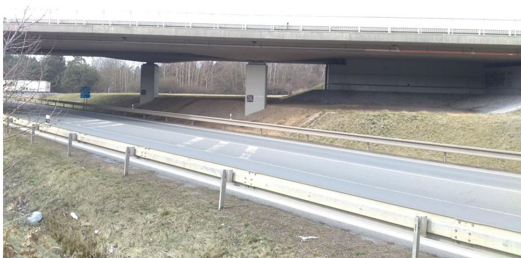
Obrázek 78: Objekt č. 4, na mapě č. 45, na silnici č. 27 (foto vlastní)
