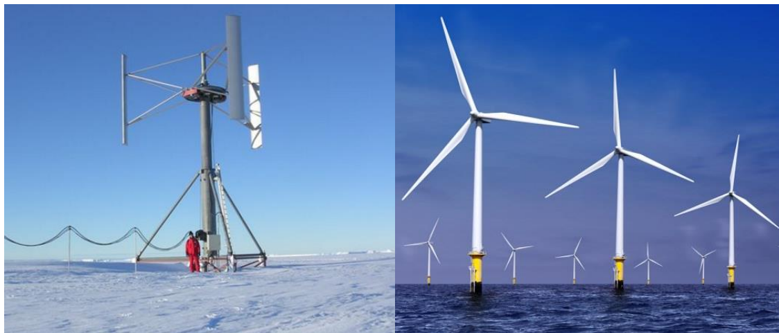
Obr. č. 4: (vlevo) Darrieova vztlaková vertikální turbína, zdroj [19], autor: Carl von Canstein. Obr. č. 5: (vpravo) Offshore park VTE, horizontální vztlakové turbíny, zdroj [38], autor: Sutterstock.
