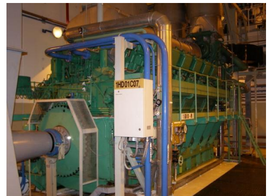
Obr. 2.7 DG bezpečnostních systémů
