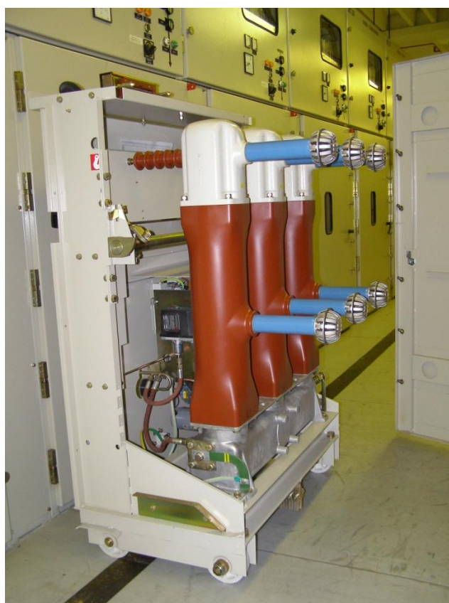
Příloha 8: Generátorový vypínač 24 kV
