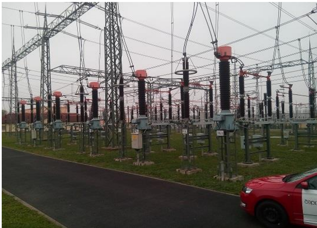
Obr. 2.4.2 – Přístrojový transformátor napětí [9]
