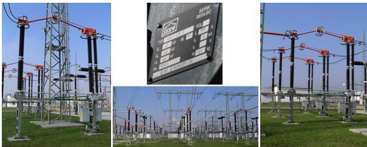
Obr. 2. 3.1 – Sklápěcí odpojovač [9]
