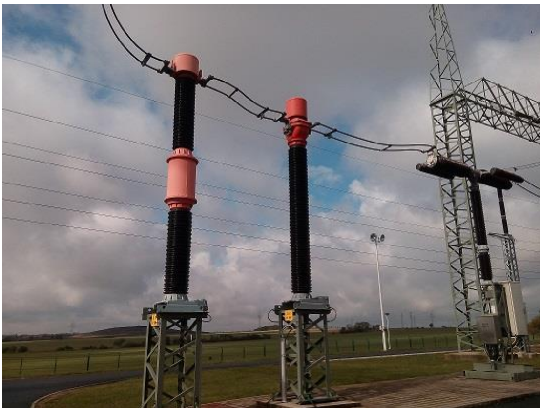
Obr. 2.4.1 – Přístrojový transformátor proudu (vlevo) a přístrojový transformátor napětí (vpravo) [9]
