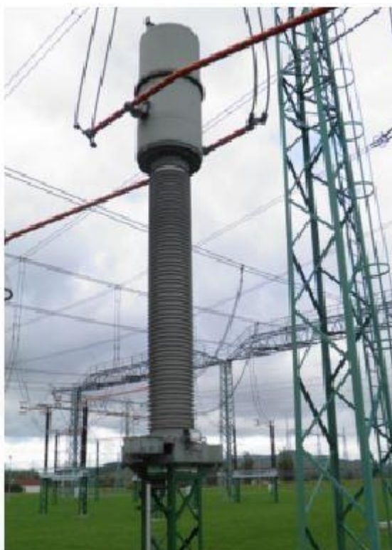
Obr. 2.4.3 – Kombinovaný přístrojový transformátor [9]
