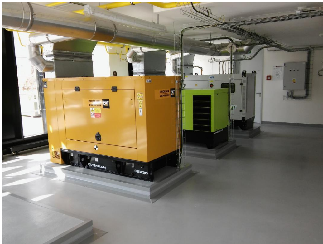
Obr. 3.15 Motorárna – diesel generátory
