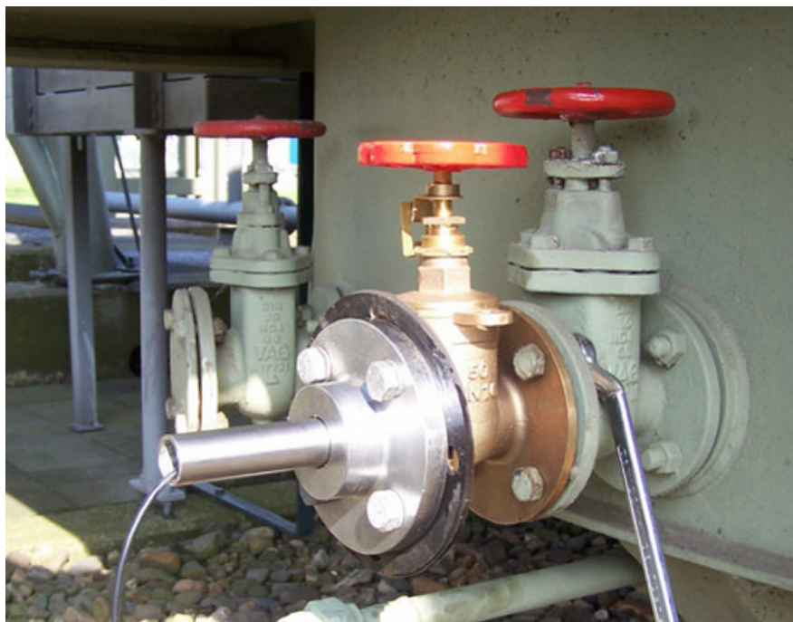
Obr. 2.16 UHF senzor přímo umístěný v olejové výpusti [14]
