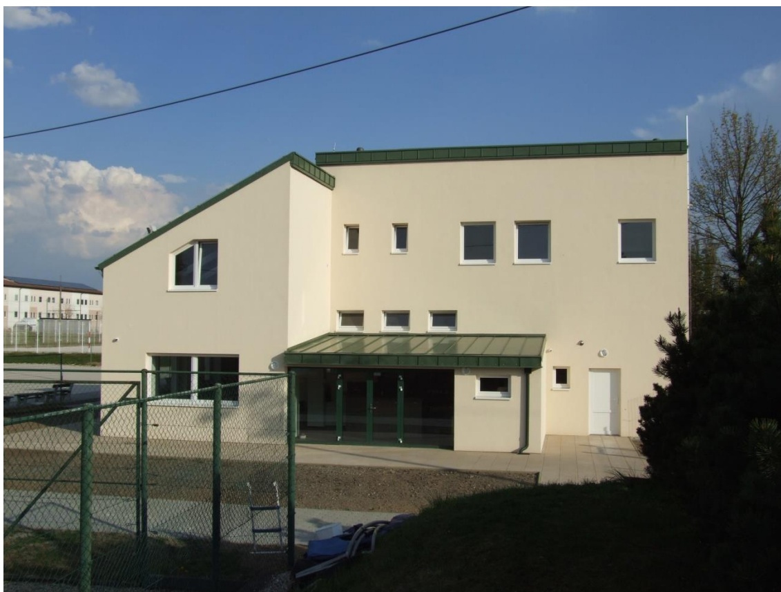
Obr. č. 11 Současný vzhled objektu šaten
