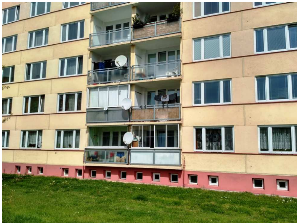
Obrázek 24: Skvrňany ulice Lábkova - obvodový plášť parapetní dílce (vlastní fotografie)
