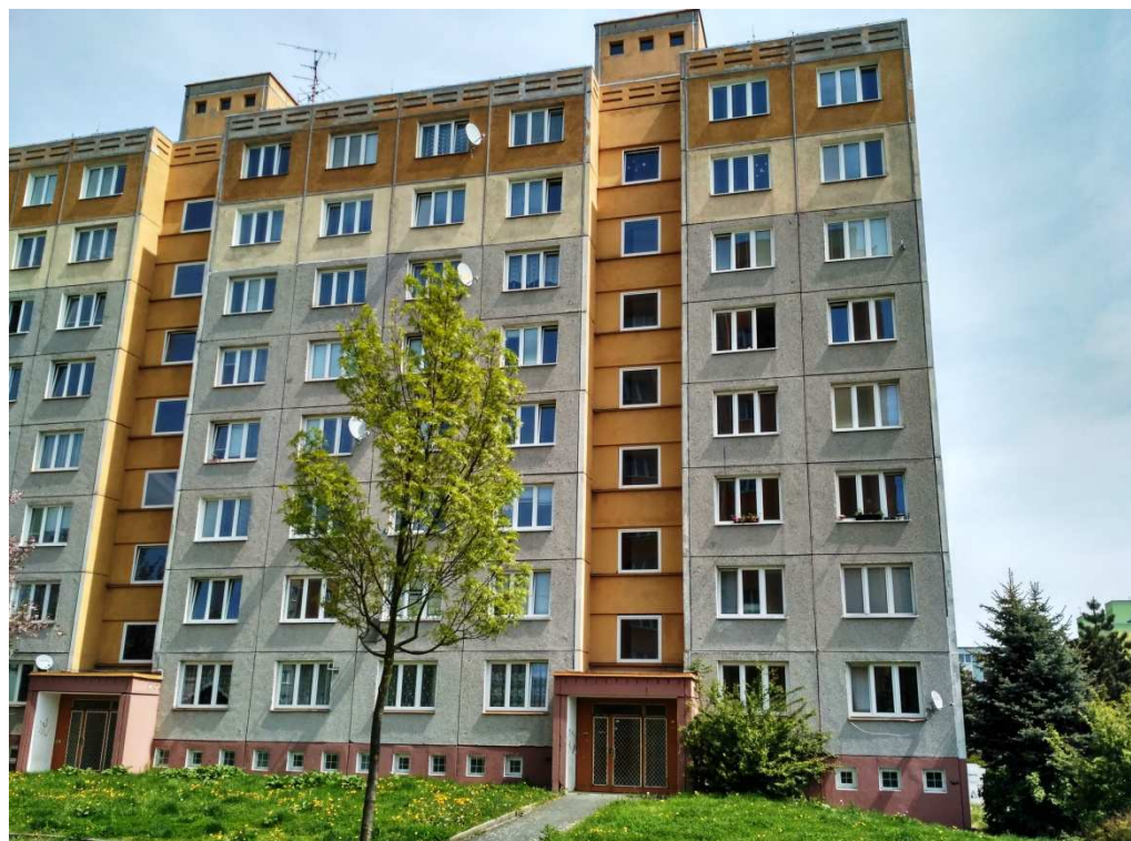
Obrázek 40: Vinice ulice Strážnická - řadové sekce (vlastní fotografie)
