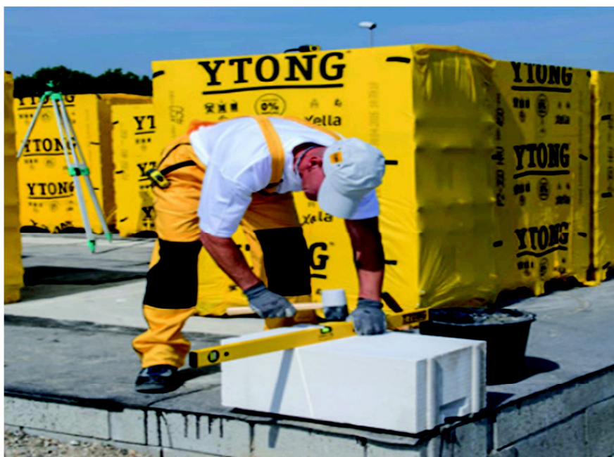
Obrázek 21: Ytong - rohové tvárnice první řady zdiva
