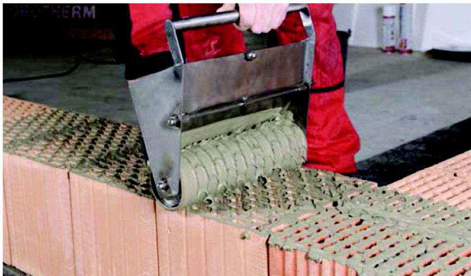
Obrázek 5: Porotherm Profi - nanášení lepidla
