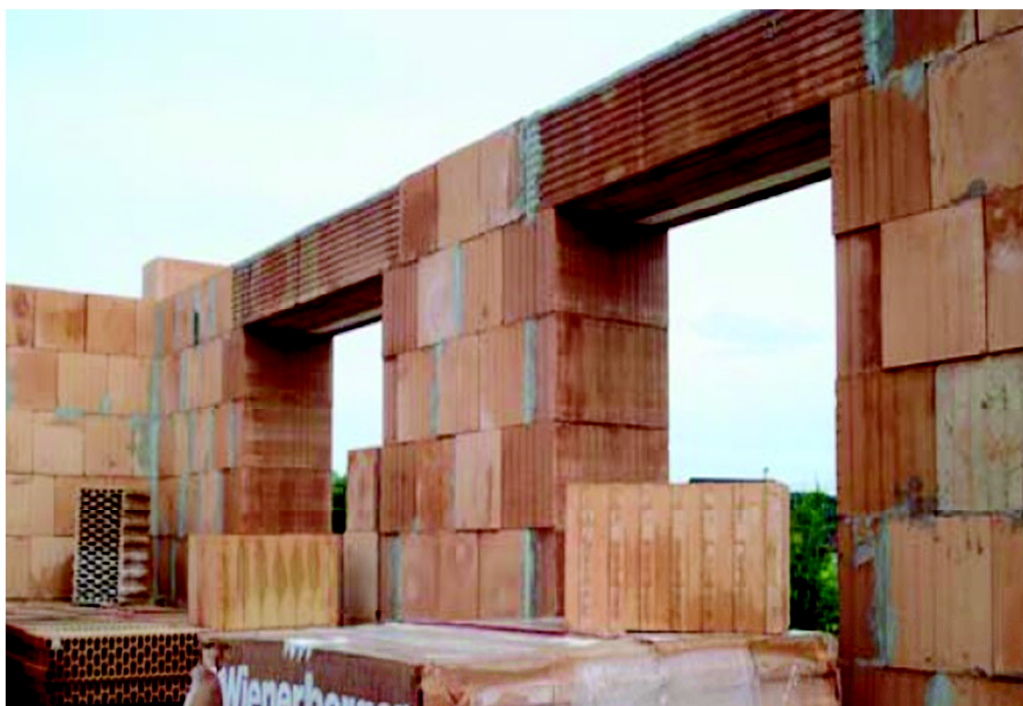
Obrázek 8: Porotherm Profi - uložení překladů
