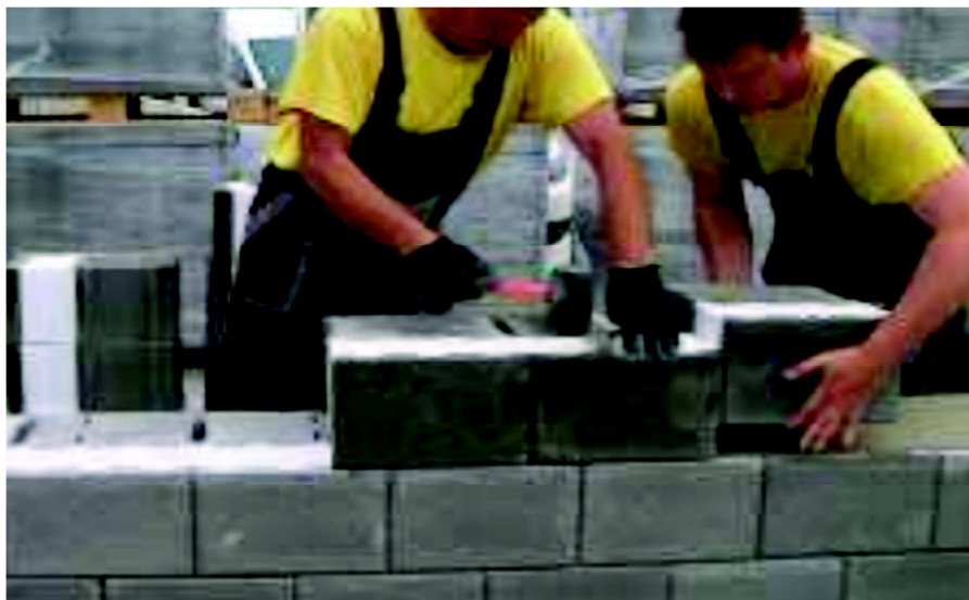
Obrázek 35: Livetherm - vazba zdiva
