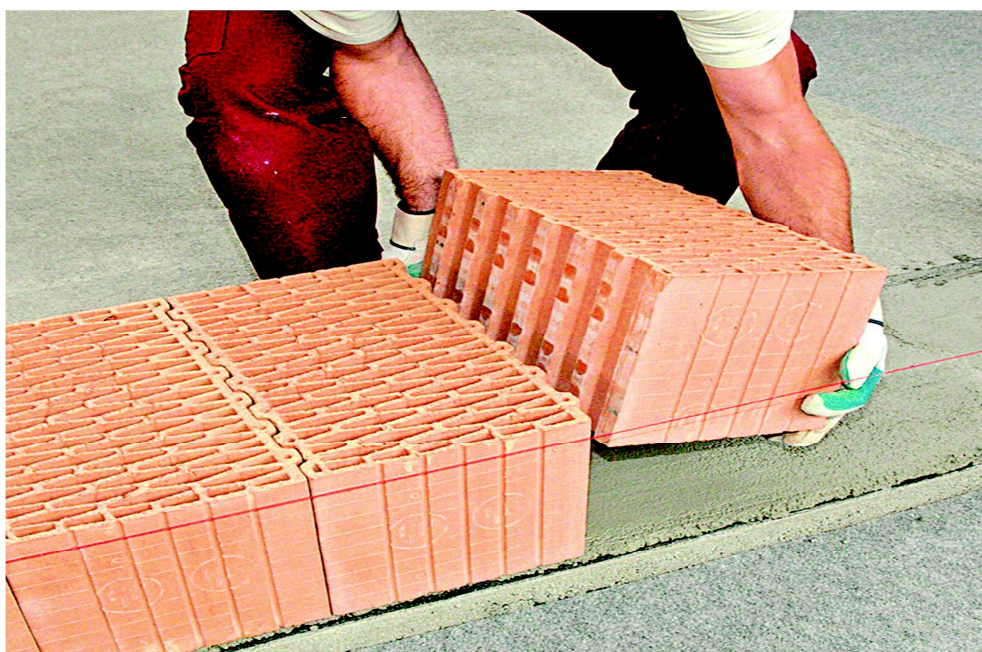
Obrázek 4: Porotherm Profi - zakládání první řady zdiva
