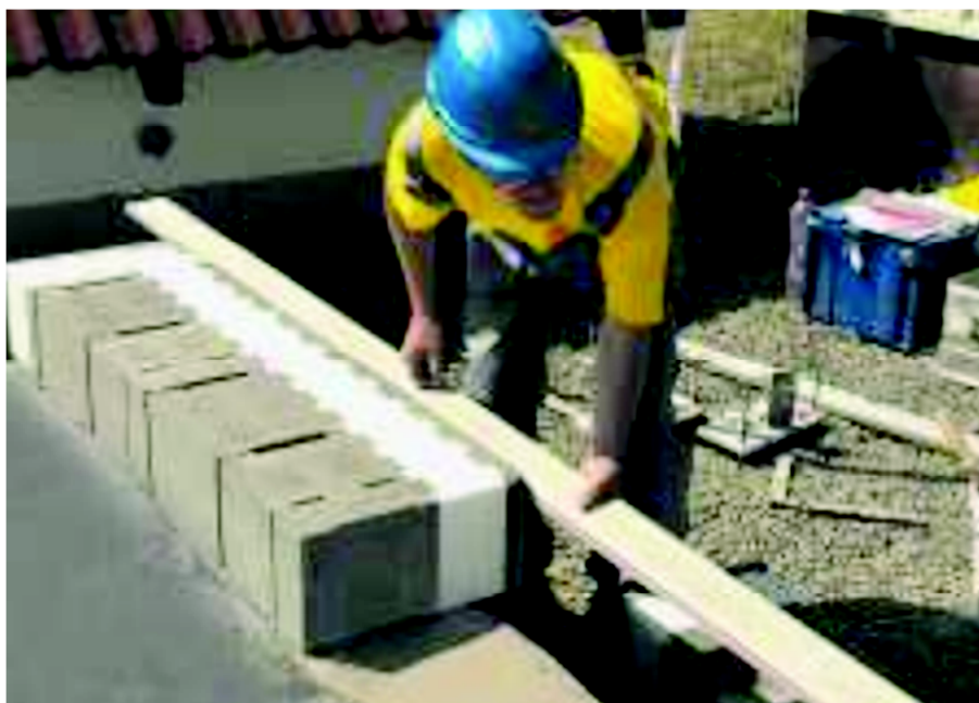
Obrázek 34: Livetherm - zakládání první řady zdiva
