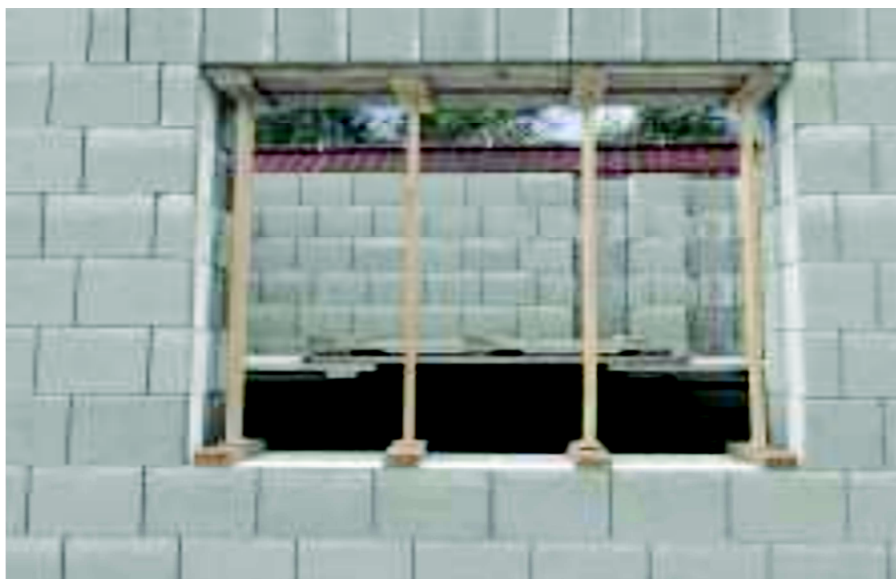
Obrázek 38: Livetherm - podepření překladů
