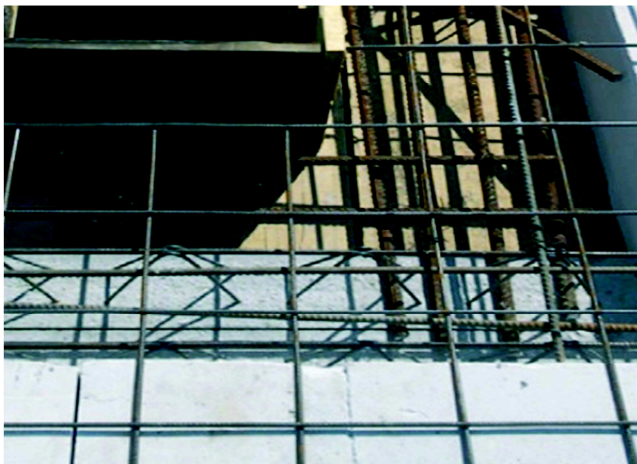
Obrázek 26: Ytong klasik - armování stropu
