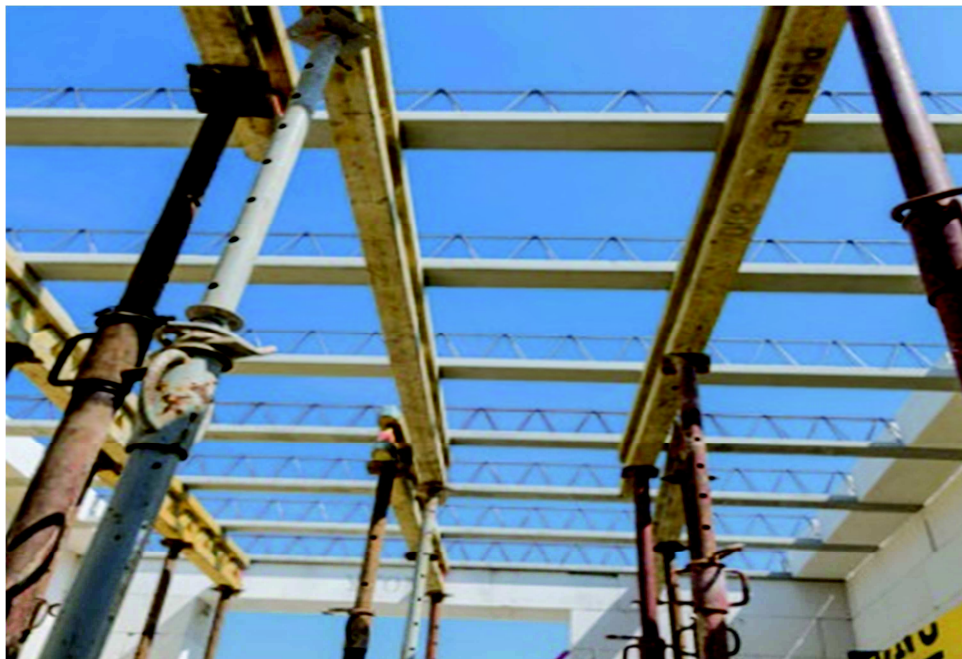
Obrázek 24: Ytong klasik - podepření stropu
