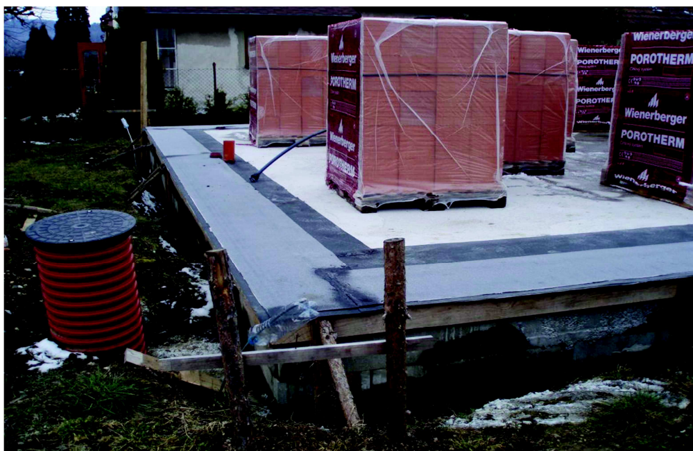
Obrázek 3: Protoherm Profi - hydroizolace
