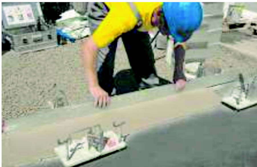
Obrázek 33: Livetherm - vyrovnání nerovností základové desky
