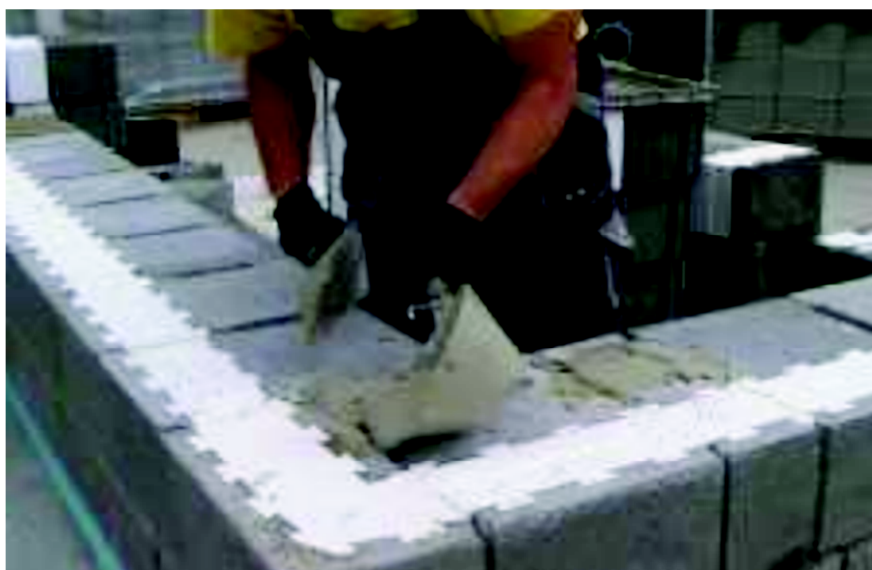
Obrázek 36: Livetherm - nanášení lepidla
