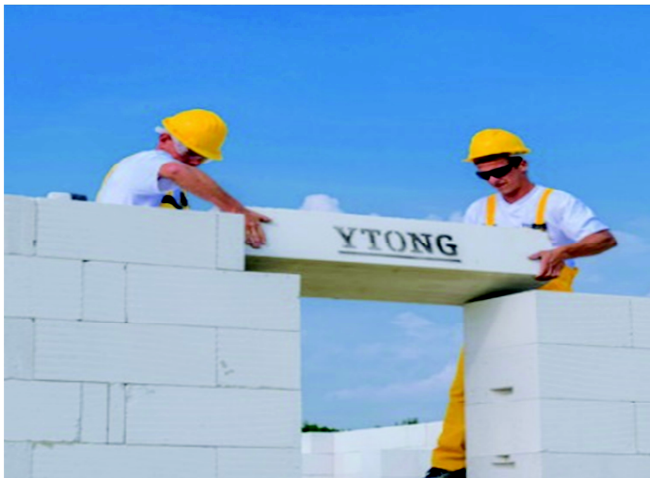
Obrázek 23: Ytong - uložení překladů
