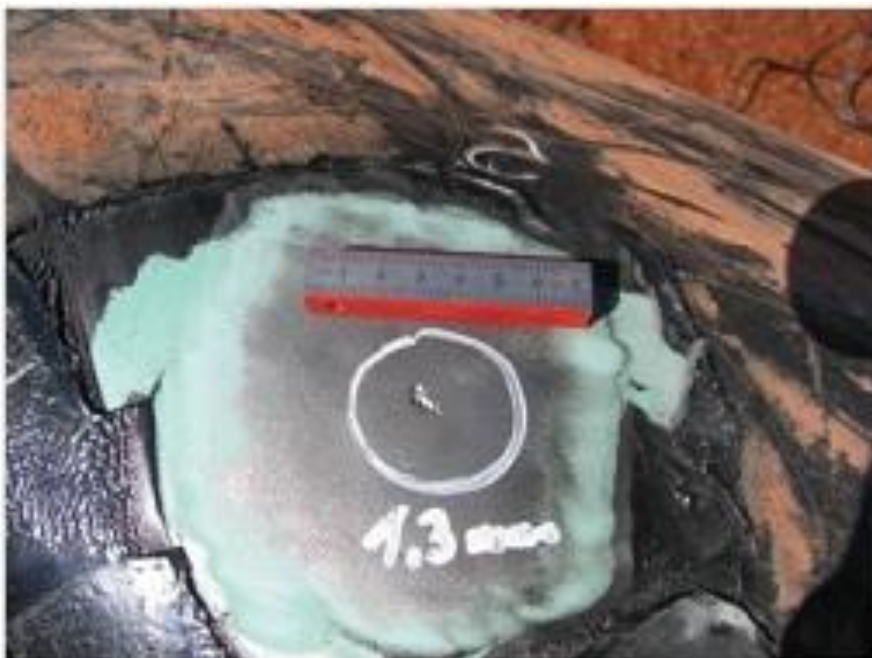
Obr. 7. Příklad koroze způsobené malým defektem v izolaci [7].
