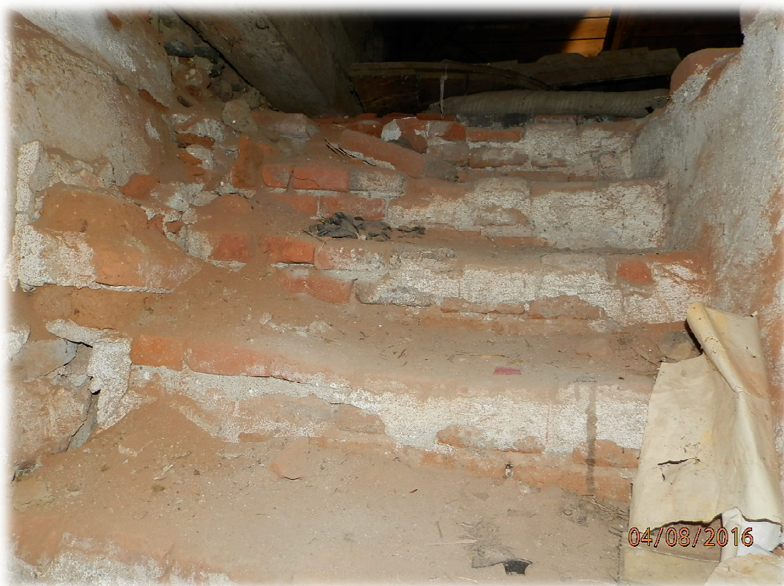
Obr. 1.11 Vnitřní schodiště do půdních prostor
