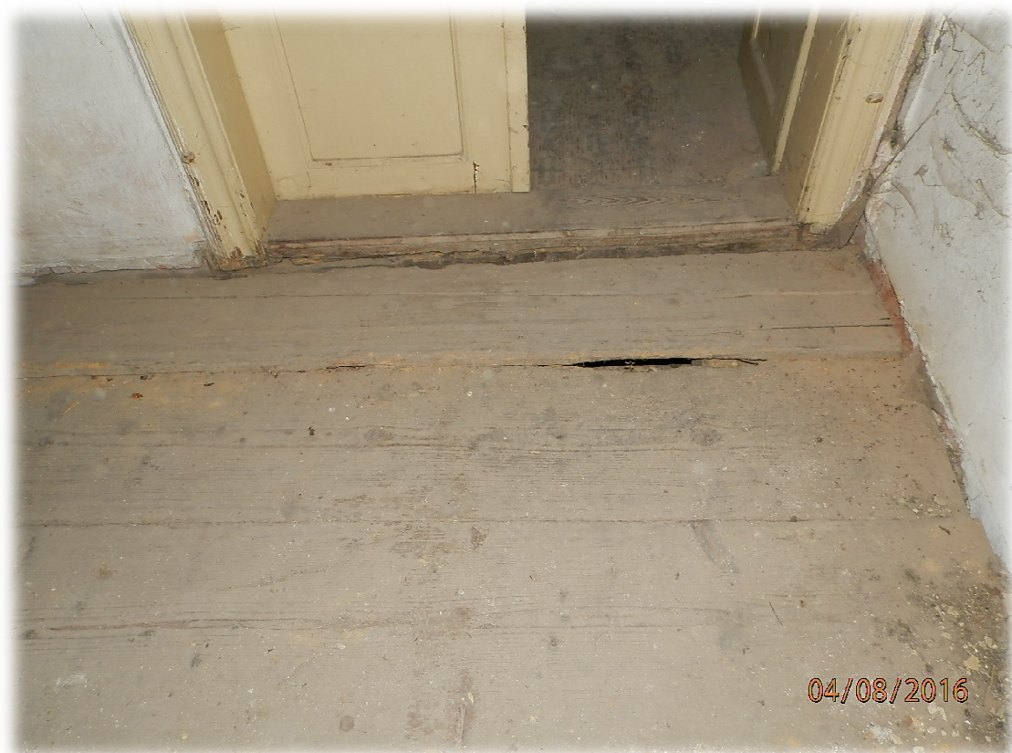
Obr. 1.14 Původní dřevěná podlaha zámku
