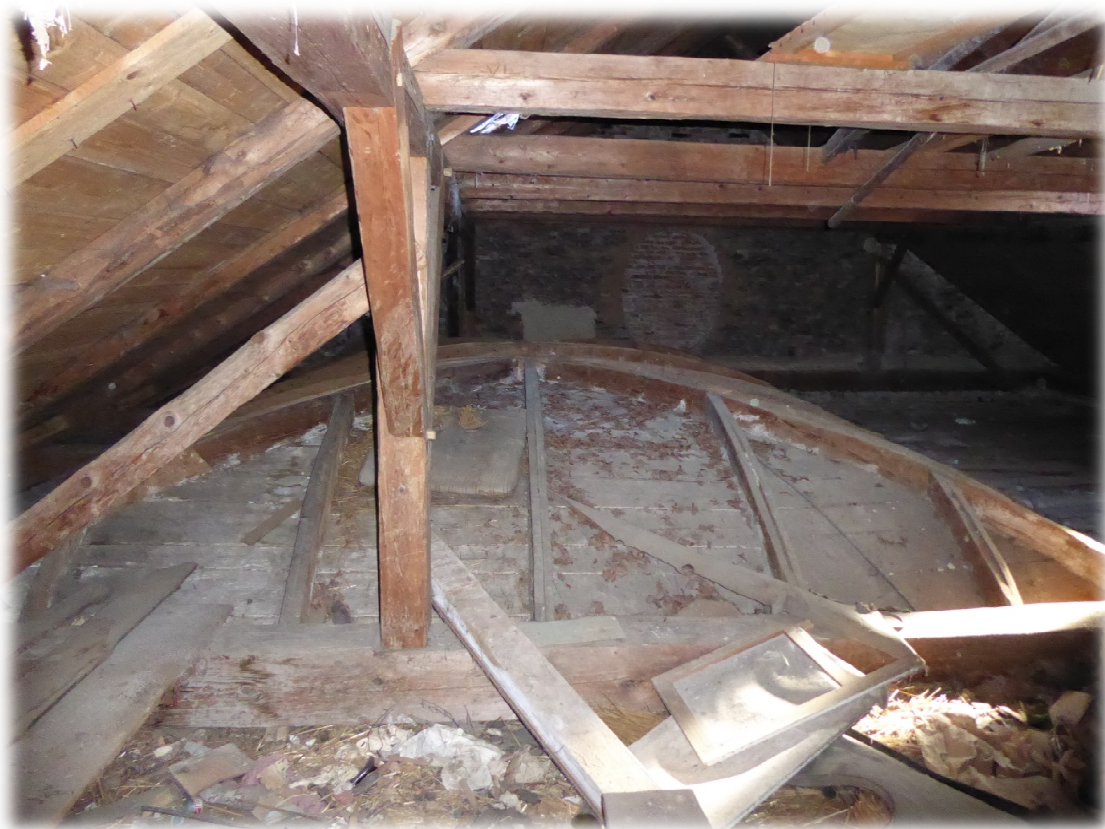
Obr. 1.4 Dřevěná klenba - příčný pohled
