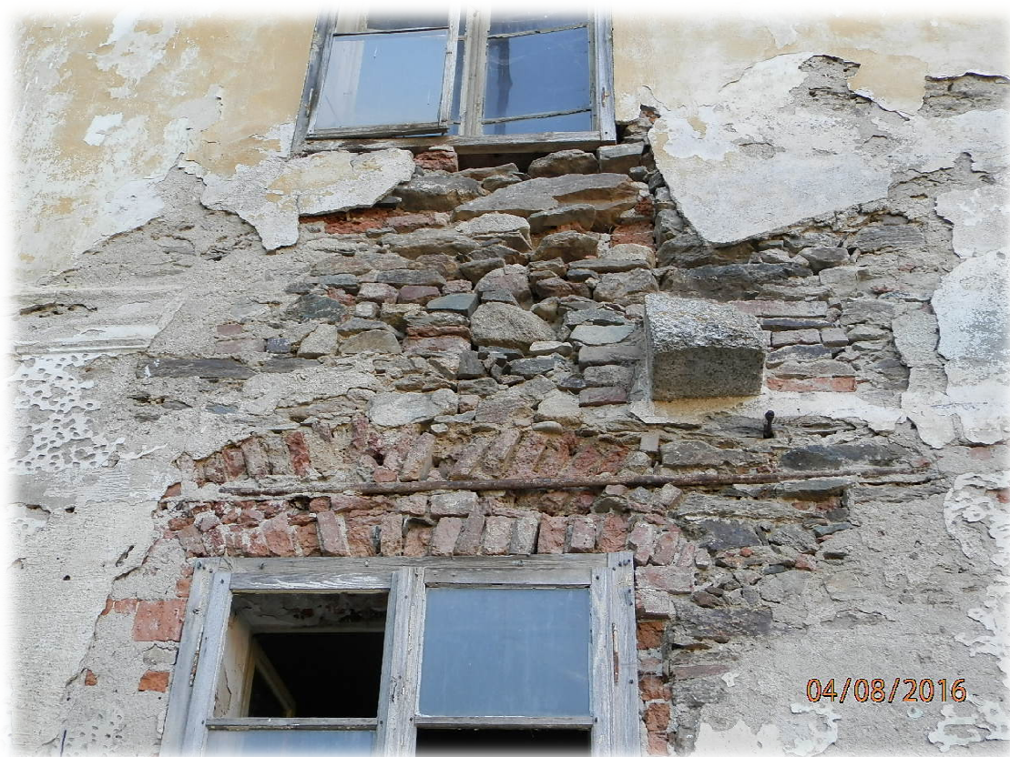
Obr. 1.8 Zděný překlád nad okenním otvorem v obvodové stěně východního průčelí zámku
