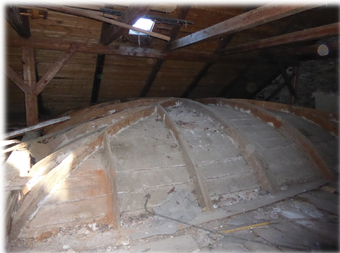
Obr. 1.5 Dřevěná klenba - podélný pohled
