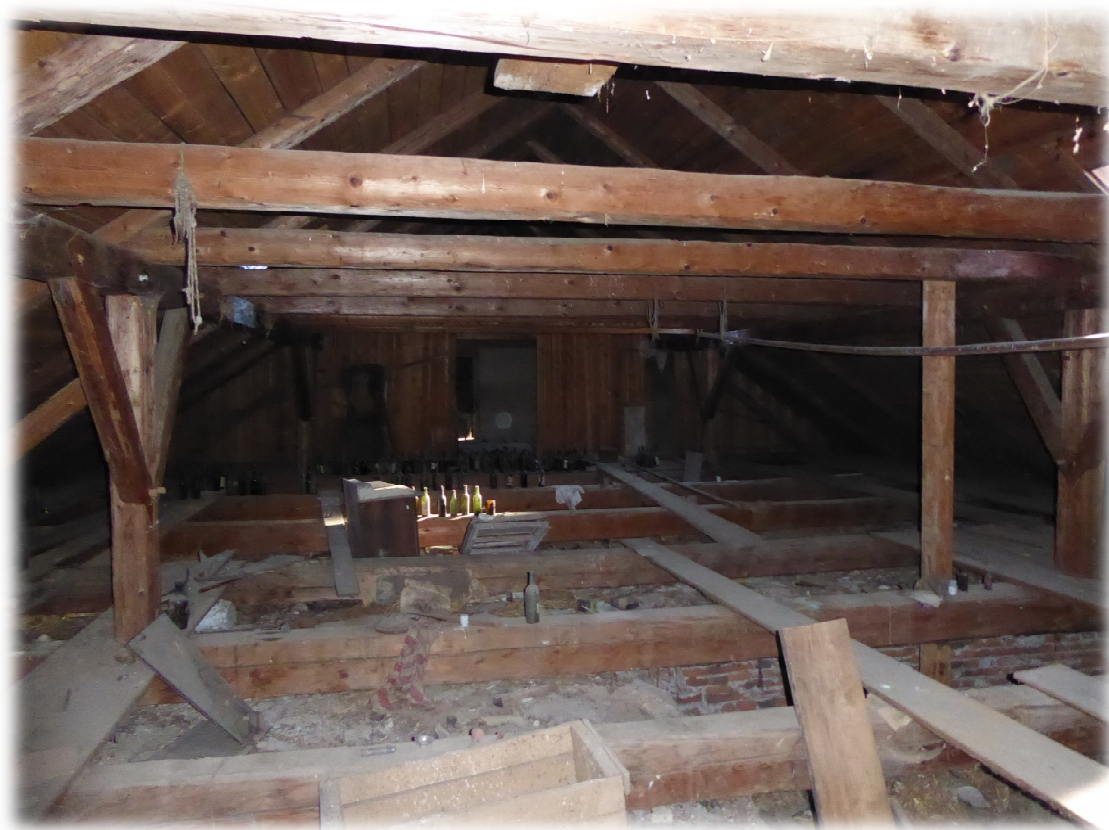
Obr. 1.12 Hambalkový krov se stojatou stolicí
