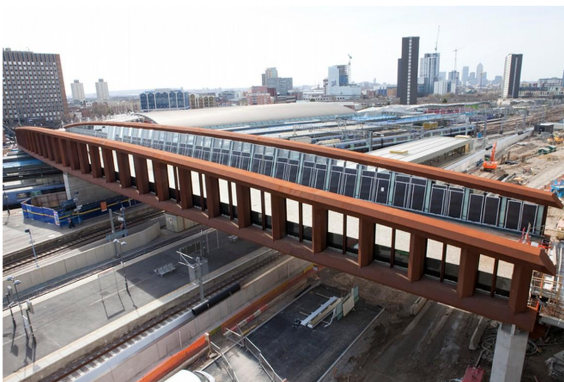
Obrázek 13: Stratford City Link Bridge, Londýn, 130m dlouhý a 14m široký most
