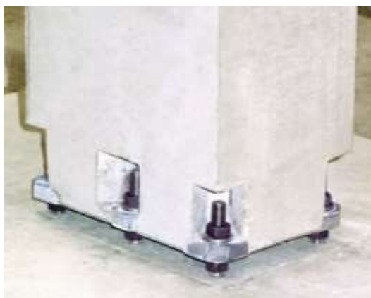
Obrázek 26: Osazení sloupů na betonovou zeď - Botky sloupů Halfen HCC
