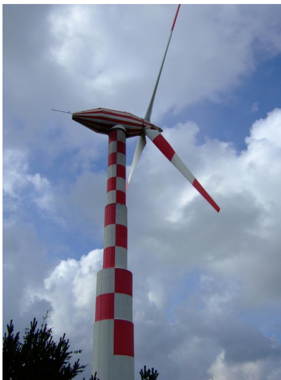
Obr. 1.3 Větrná elektrárna postavená učiteli a studenty, Tvind, Dánsko
