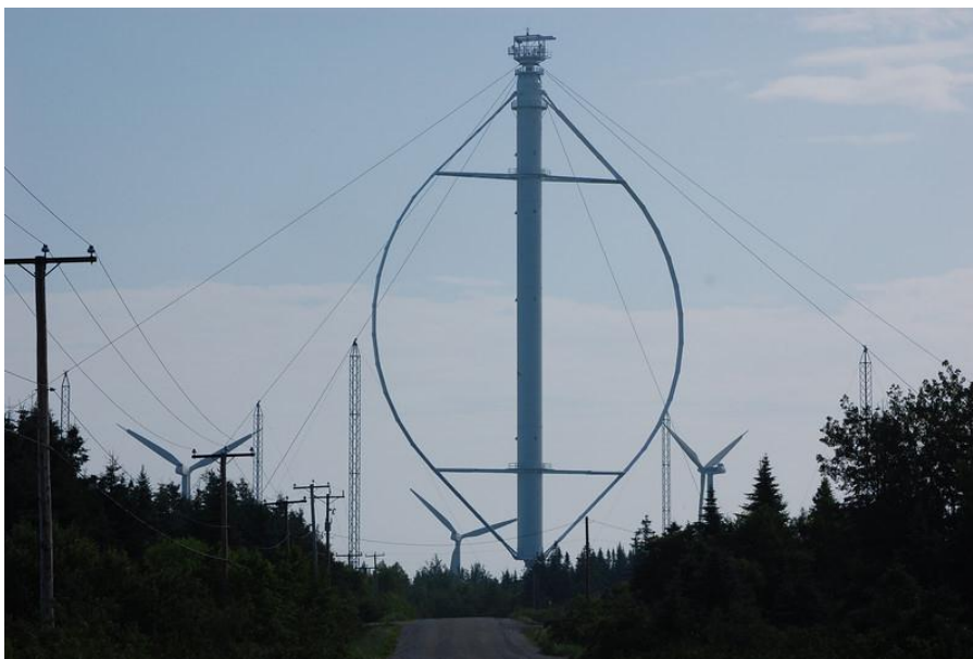
Obr. 1.4 Éole, největší větrná elektrárna se svislým rotorem, oblast Cap-Chat, Quebec, Kanada
