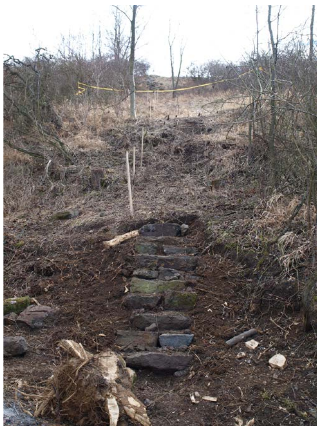
obrázek 10 – průběh práce, 1. den práce
