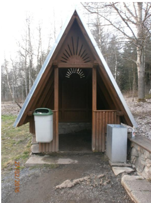
Obr. 13: Zastřešená studánka v Nepomuku (27.2.2016)
