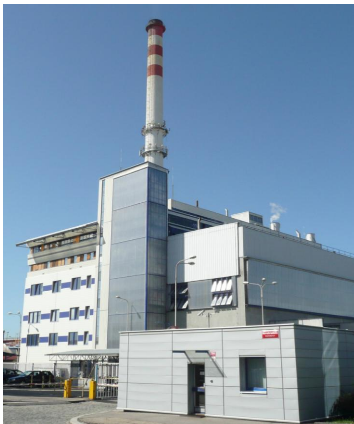
Obr. 2.5 Teplárna v Českých Budějovicích, Novohradská 32
