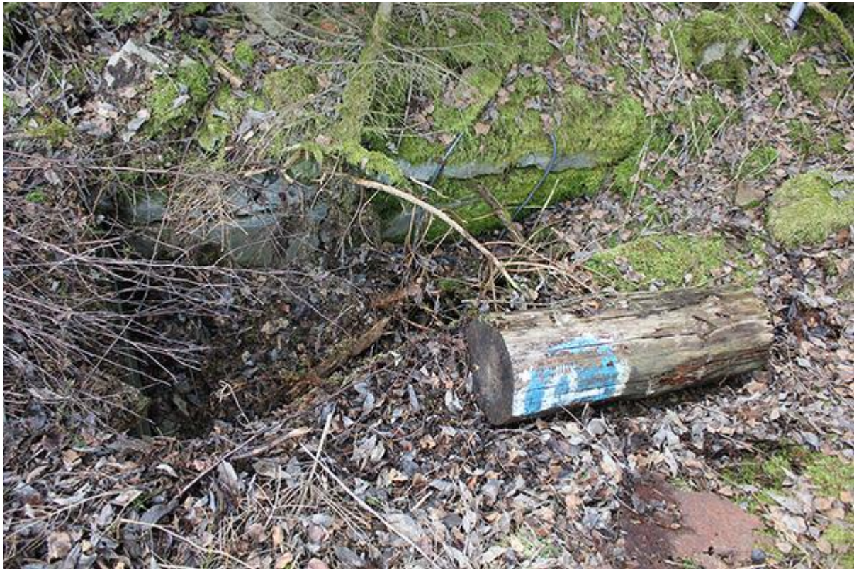
Obr. 20. a 21. Objekt 5. který mohl sloužit jako montážní jáma.
