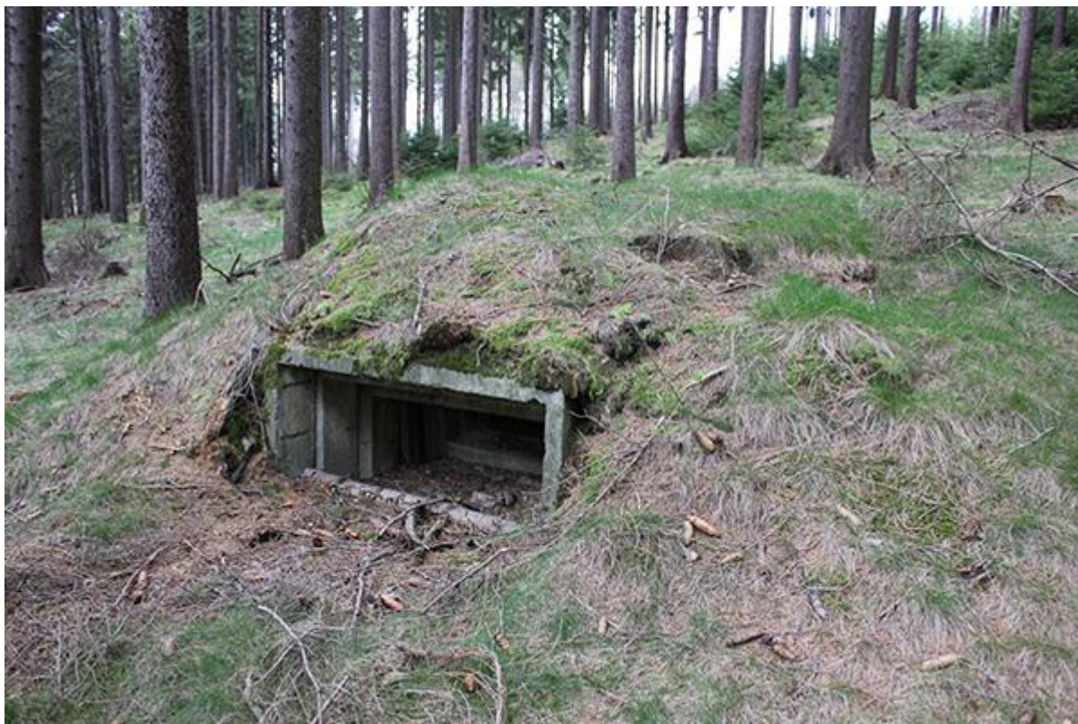
Obr. 30. (Zleva) Detail pozorovacího průzoru.
