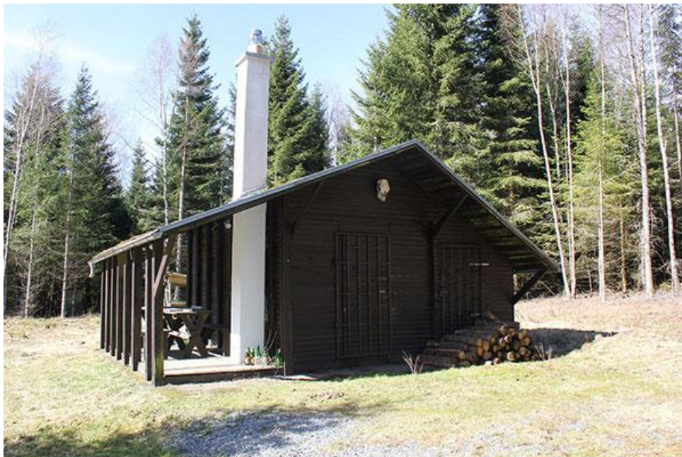
Obr. 45. Novodobá chata a jediná stavba na lokalitě Mohelno.
