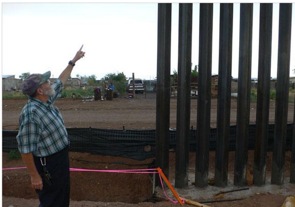
Obrázek 2: Výstavba ocelových sloupů, které tvoří hraniční zeď.
