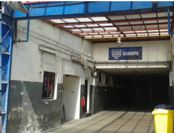
Obr. 20 - Vstup do haly konvertovanej na telocvičňu. Zdroj: vlastný archív.
