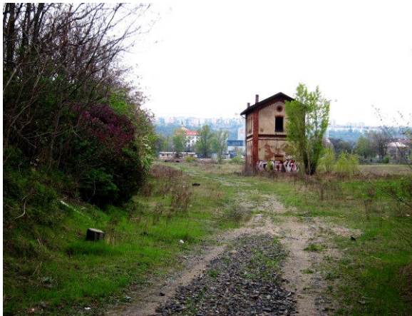
Obr. 9 - Posledná pamiatkovo chránená stavba - vodáreň. Zdroj: vlastný archív.
