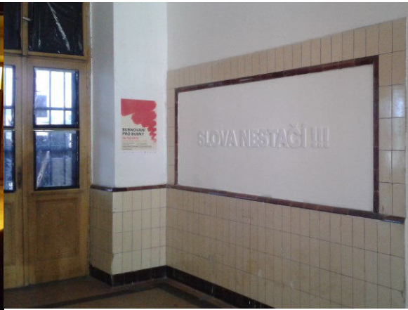
Obr. 16 - Vestibul staničnej budovy. Zdroj: vlastný archív.
