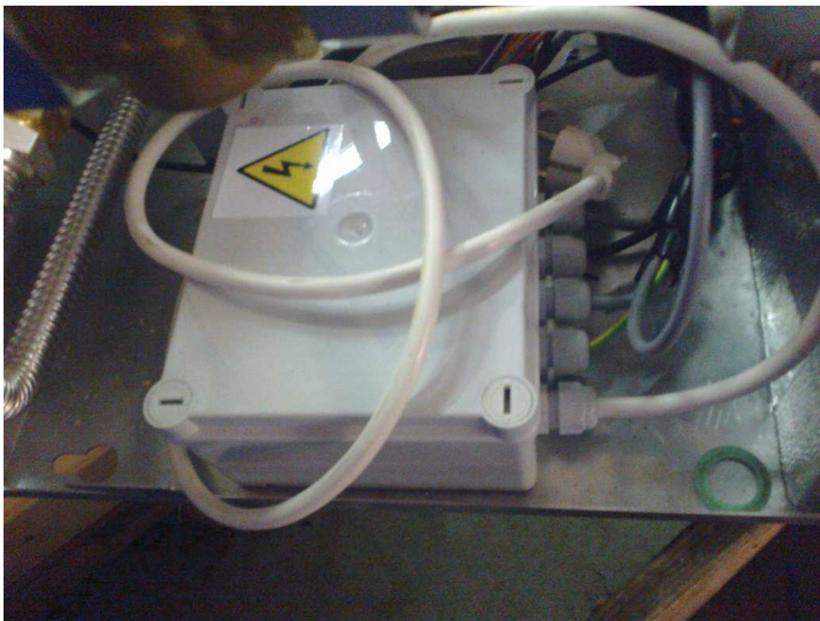
Obrázek 16: Měření spojitosti ochranných obvodů a zkouška izolace vodičů
