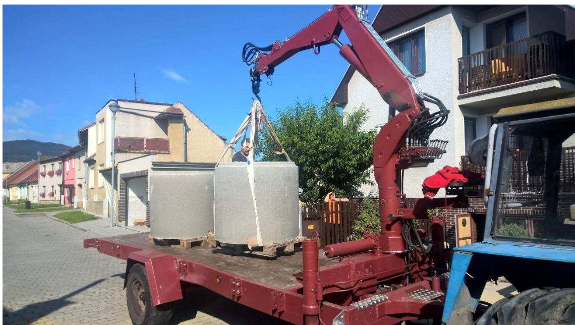
17. Fotka vleku při pokládání betonových skruží do nové studny
