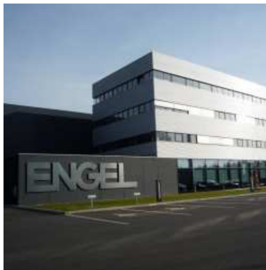
Obrázek 1 - Budova firmy ENGEL v Kaplici
