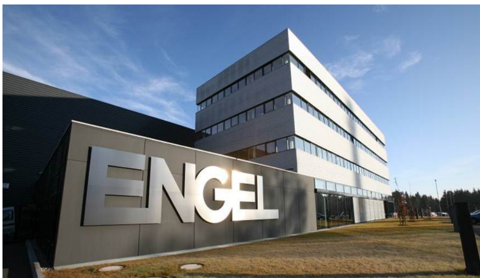
Obr. 3.1 Výrobní závod ENGEL Kaplice
